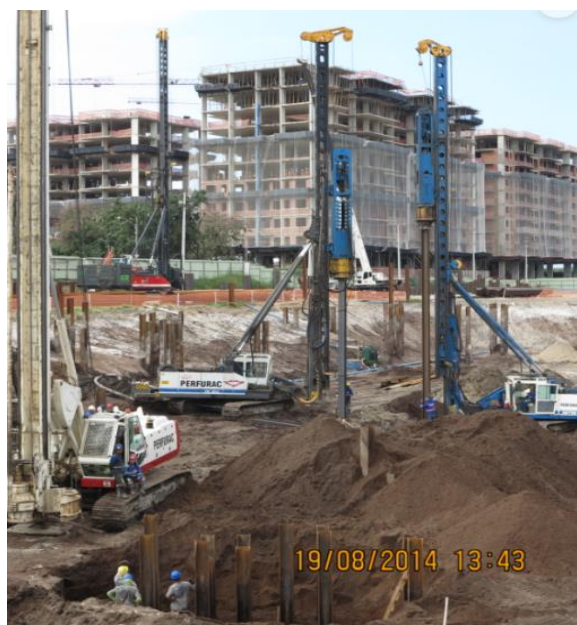
Figura 11 - Bate-estacas cravando perfis metálicos.
