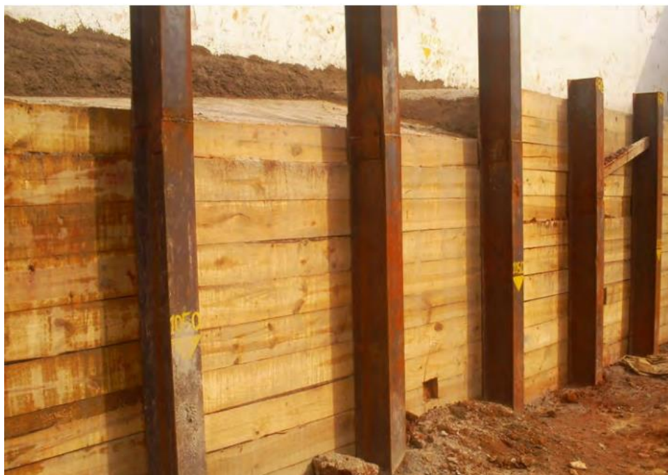
Figura 12 - Prancheamento de madeira por trás dos perfis metálicos.
