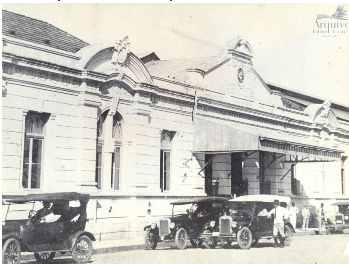
Figura 7 – Fachada da Estação Ferroviária de Rio Claro/SP
