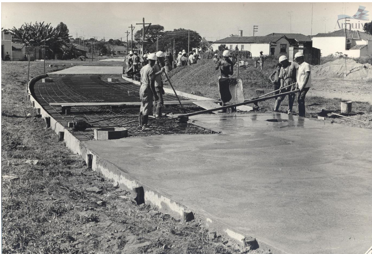
Figura 8 – Obras no córrego da Servidão
