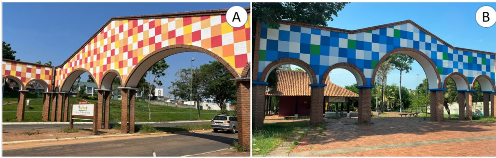
Figura 23 – Pórtico localizado no polígono 32 (A) e no polígono 6 (B)
