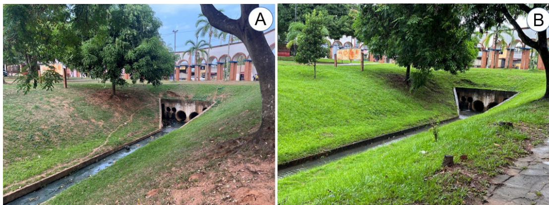
Figura 12 – Cobertura do solo em observação visual do polígono 1 no período seco (A) e chuvoso (B)
