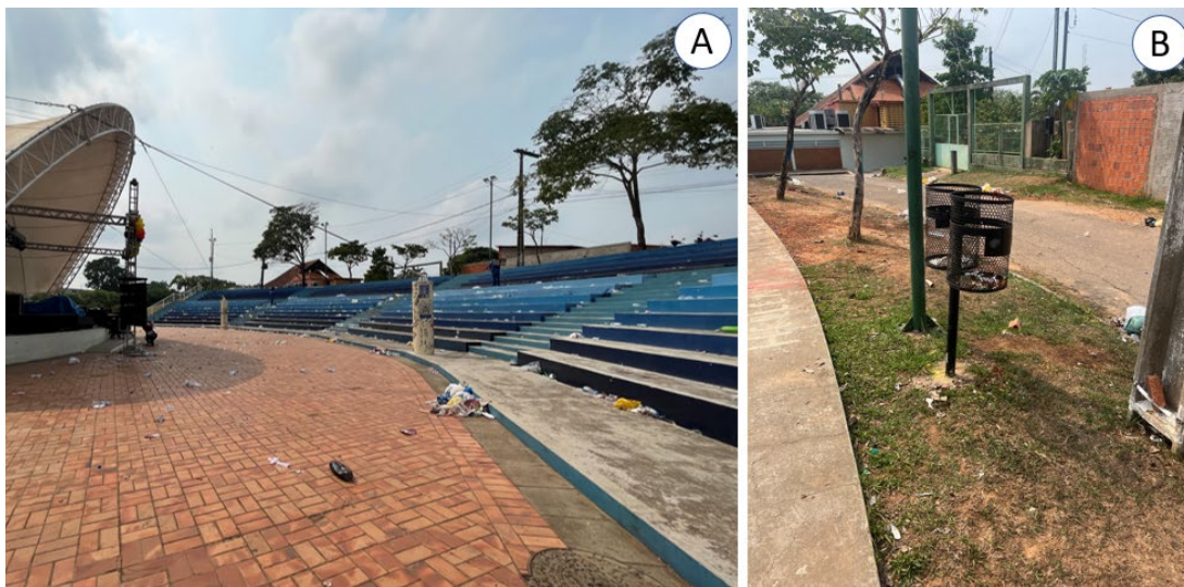
Figura 20 – Resíduos espalhados por toda a arquibancada no segmento 42 (A) e lixeira próxima ao local (B)
