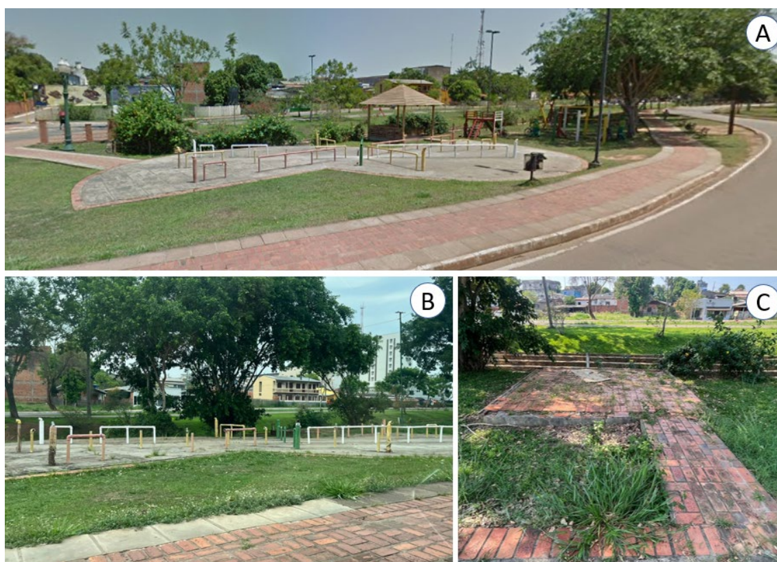
Figura 22 – Área de lazer com playground e sombreador (A), área deteriorada e parquinho ausente (B) e área onde o sombreador foi demolido (C)
