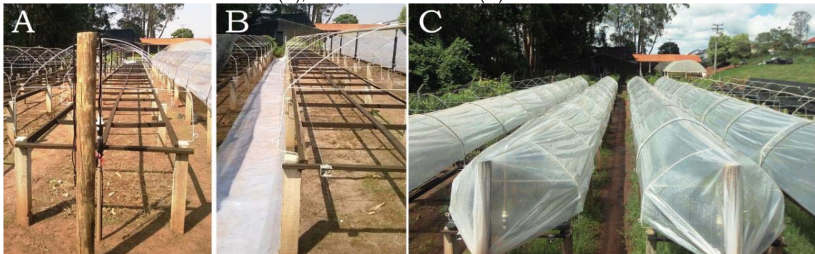
Figura 1 - Pilares de concreto, vigas e mourões de madeira e arcos metálicos (A); Plástico difusor de luz utilizado na cobertura dos canteiros (B); canteiros finalizados (C)
