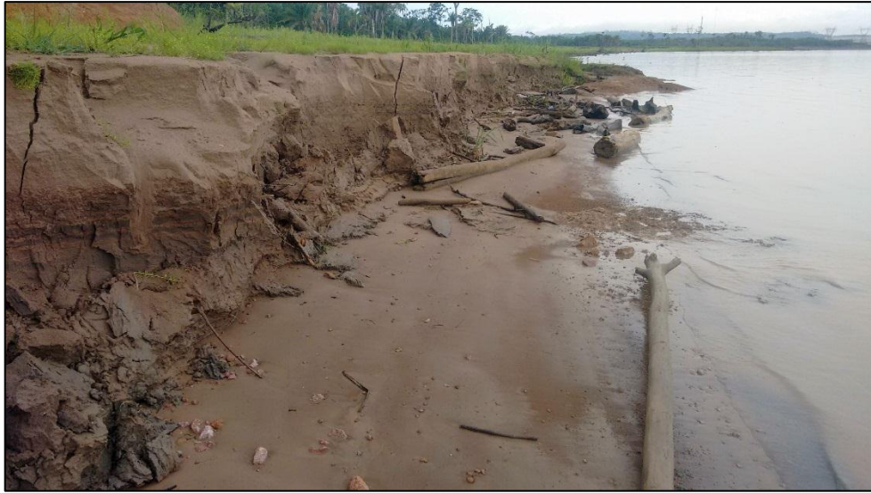
Figura 36 - Processo de erosão das margens do Rio Madeira.
