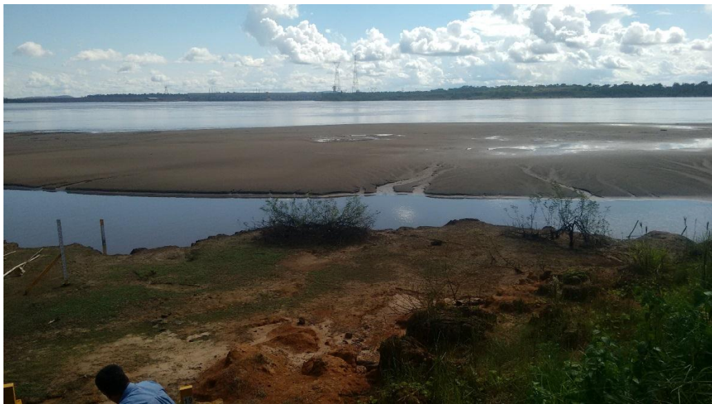
Figura 37 – Jusante da UHE Jirau com acúmulo de sedimentos (assoreamento).
