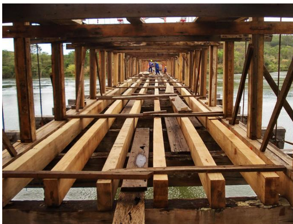
Figura 10: Ponte Pênsil Alves Lima sendo restaurada
