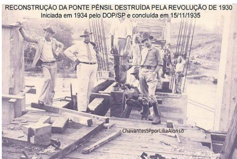
Figura 5: Reconstrução da Ponte Pênsil Alves Lima (1934-1935)
