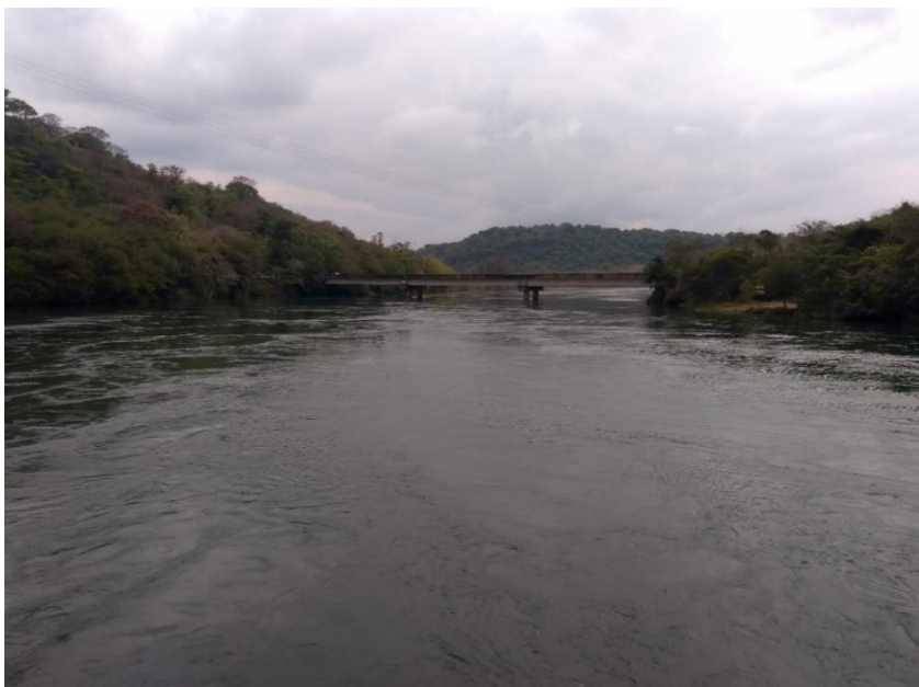
Figura 9: Ponte de concreto construída em 2006
