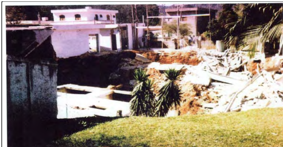
Figura 4. Cratera engolindo uma das casas, em 1986. Fonte: Ferreira, 2008.
