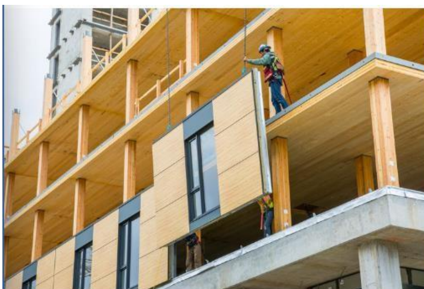
Figura 15 - Montagem do prédio
