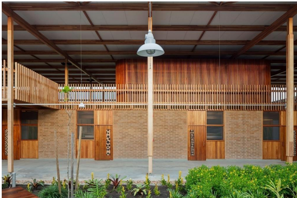
Figura 18 - Pavimento térreo com tijolo e mezanino da edificação
