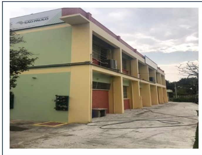
Figura 1 - Prédio da escola Etec de São José dos Campos
