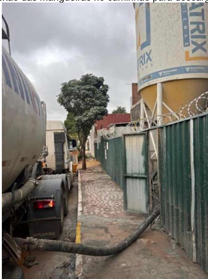
Figura 8 – Conexão das mangueiras no caminhão para descarga de argamassa
