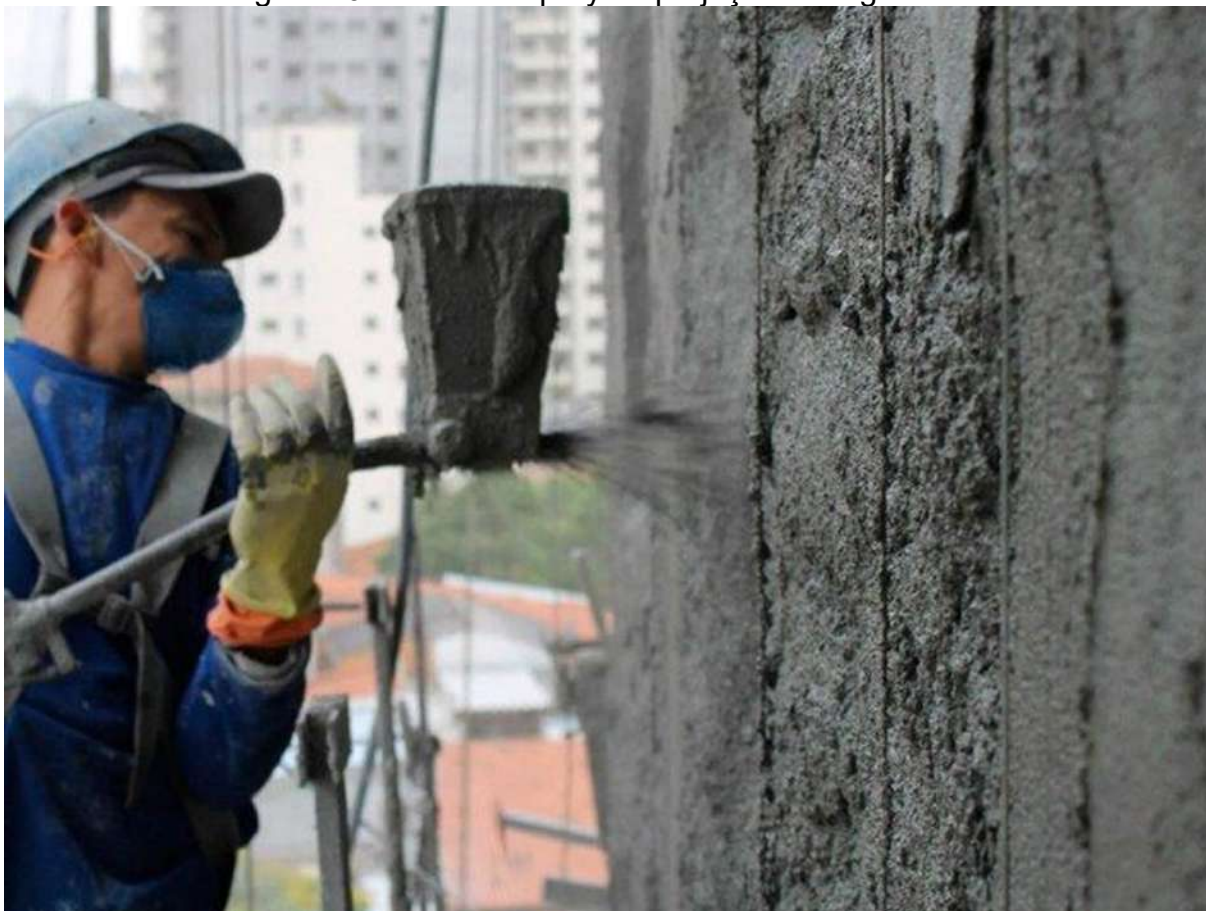
Figura 20 – Sistema spray de projeção de argamassa
