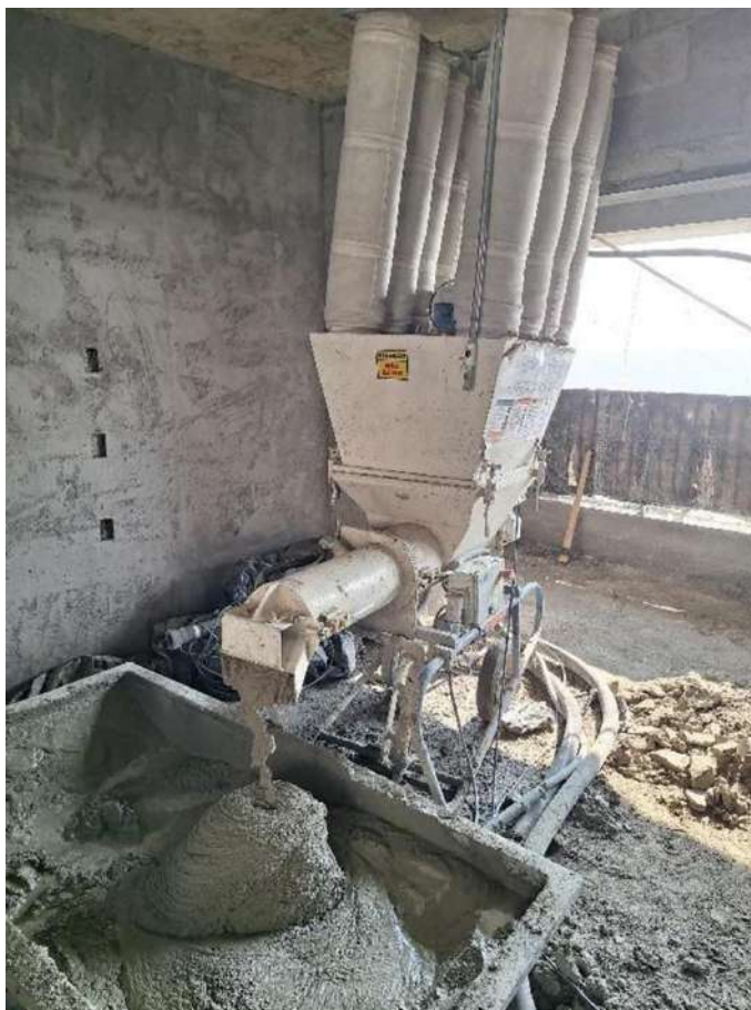
Figura 13 – Misturador móvel em funcionamento
