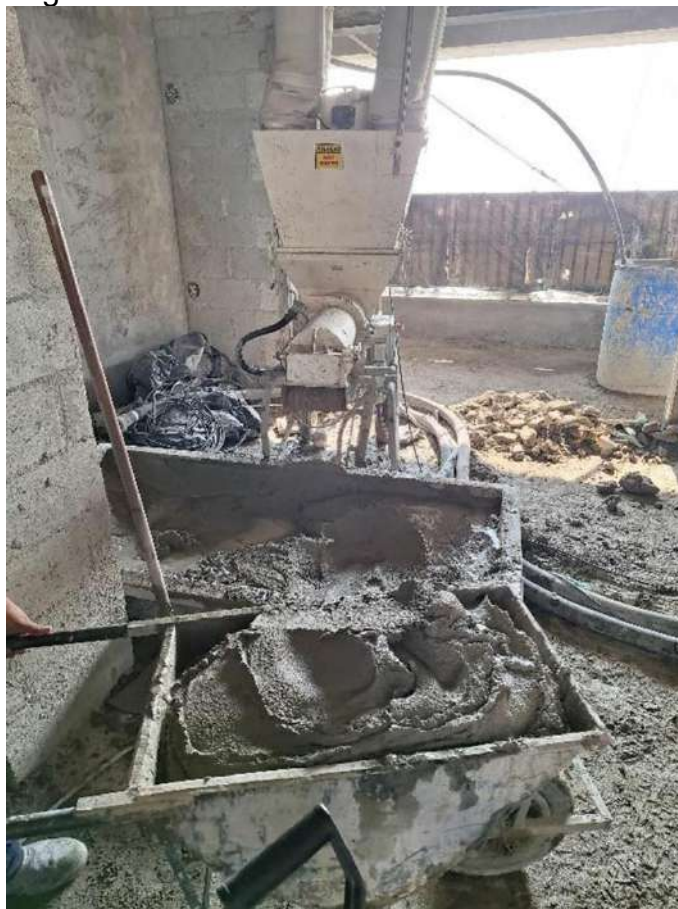
Figura 14 – Misturador móvel e uso de carriola
