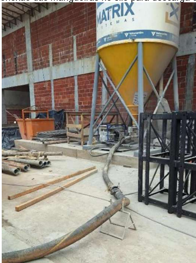
Figura 9 – Conexão das mangueiras no silo para descarga de argamassa
