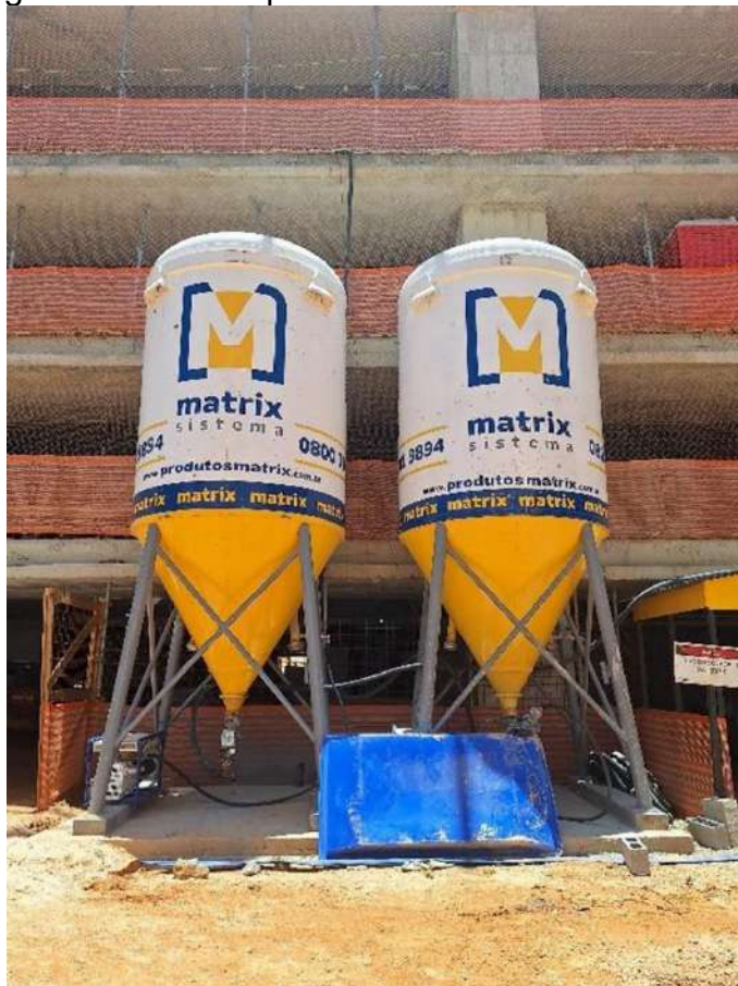
Figura 29 – Silos apoiados sobre bases de concreto
