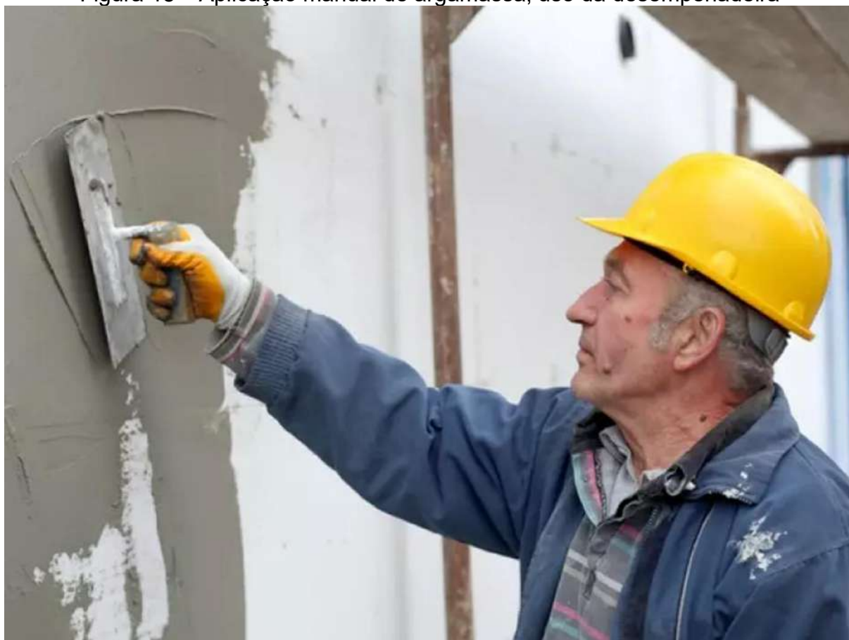
Figura 18 – Aplicação manual de argamassa, uso da desempenadeira
