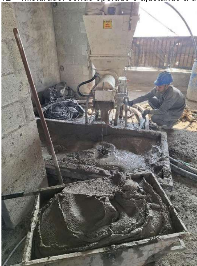
Figura 12 – Misturador sendo operado e ajustando a dosagem
