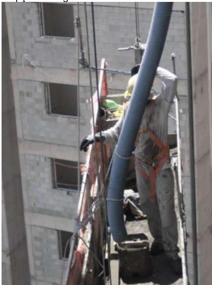
Figura 17 – Recepção de argamassa fresca no balancim através de um funil
