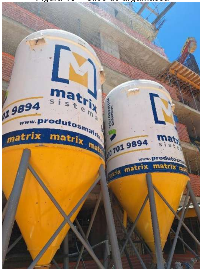
Figura 10 – Silos de argamassa
