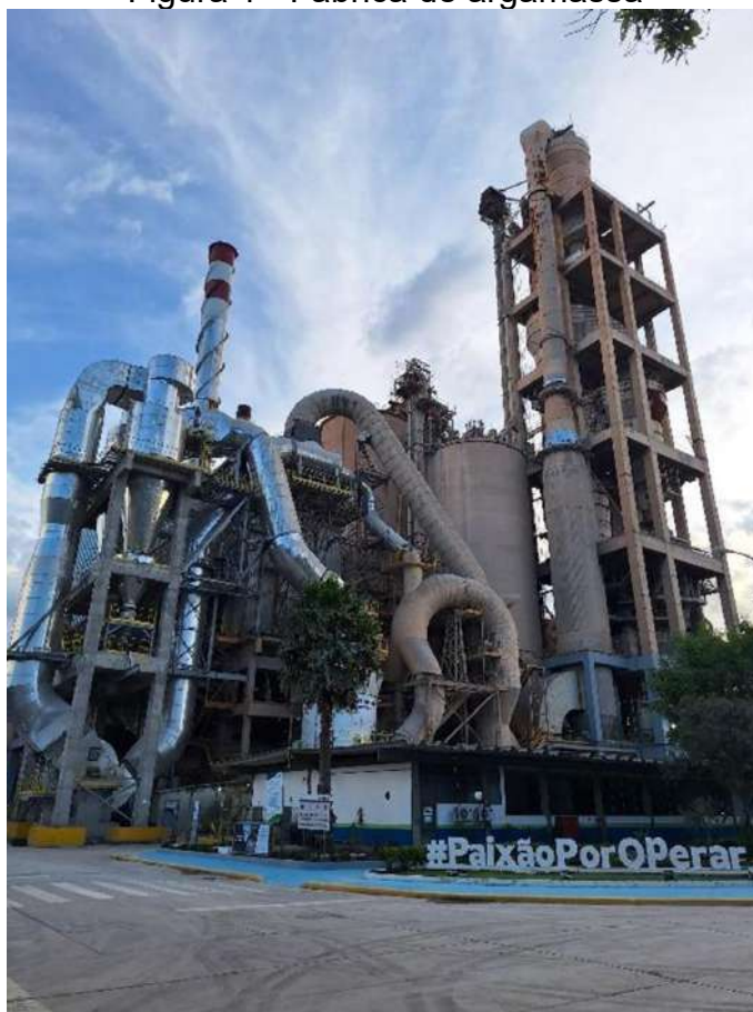
Figura 1 - Fábrica de argamassa
