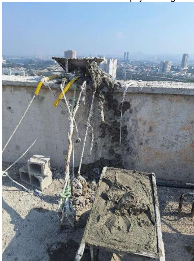
Figura 15 – Funil fixado e indícios de despejo da argamassa fresca
