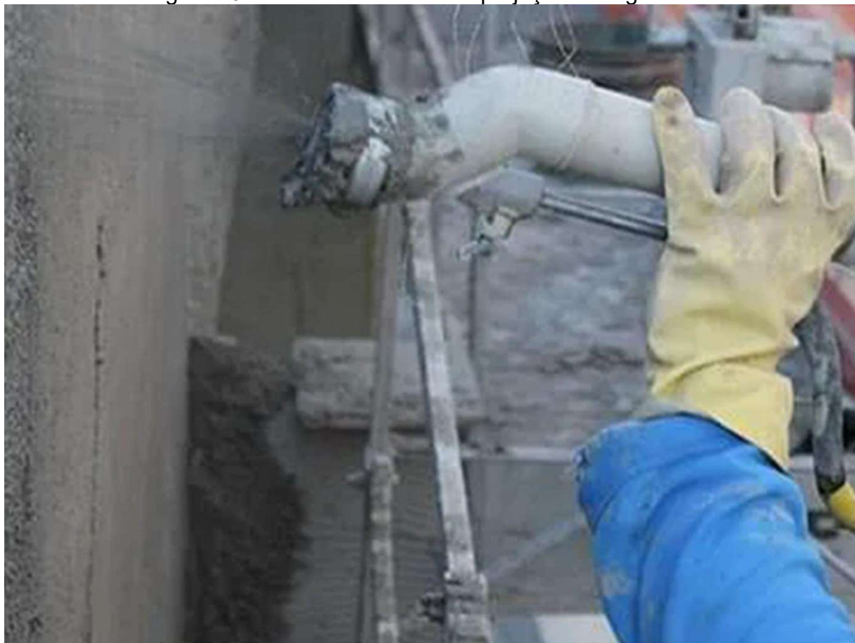
Figura 19 – Sistema contínuo de projeção de argamassa
