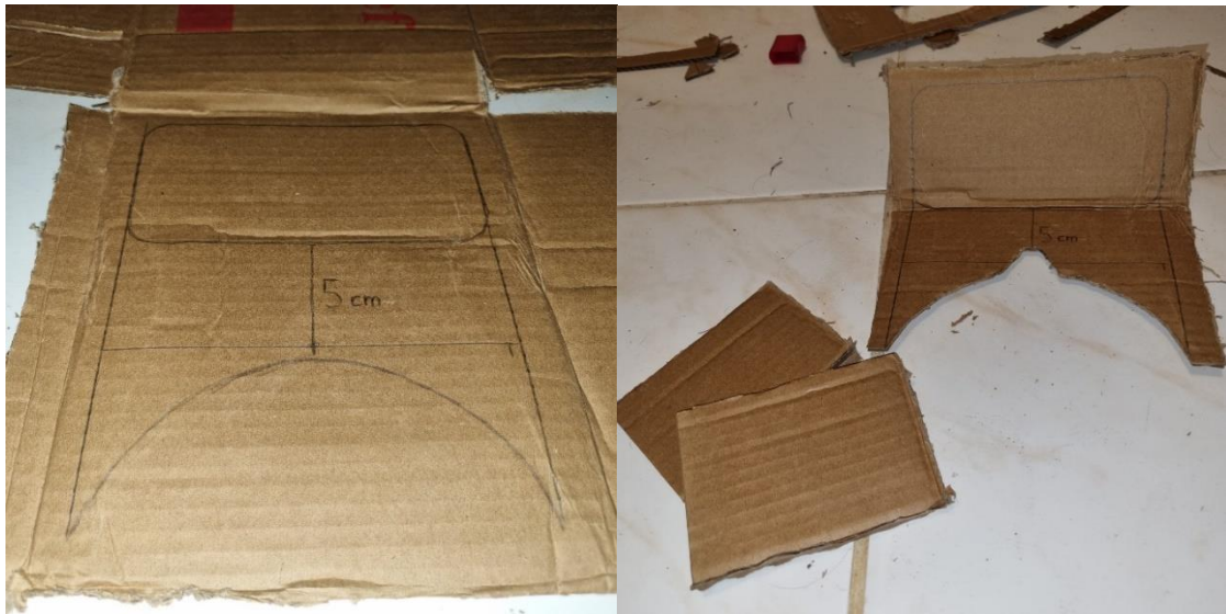
Figura 32 - Construção da estrutura do suporte do celular
