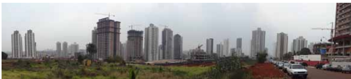
Foto 4. Edifícios em construção na Gleba Palhano. Londrina. 2013.
