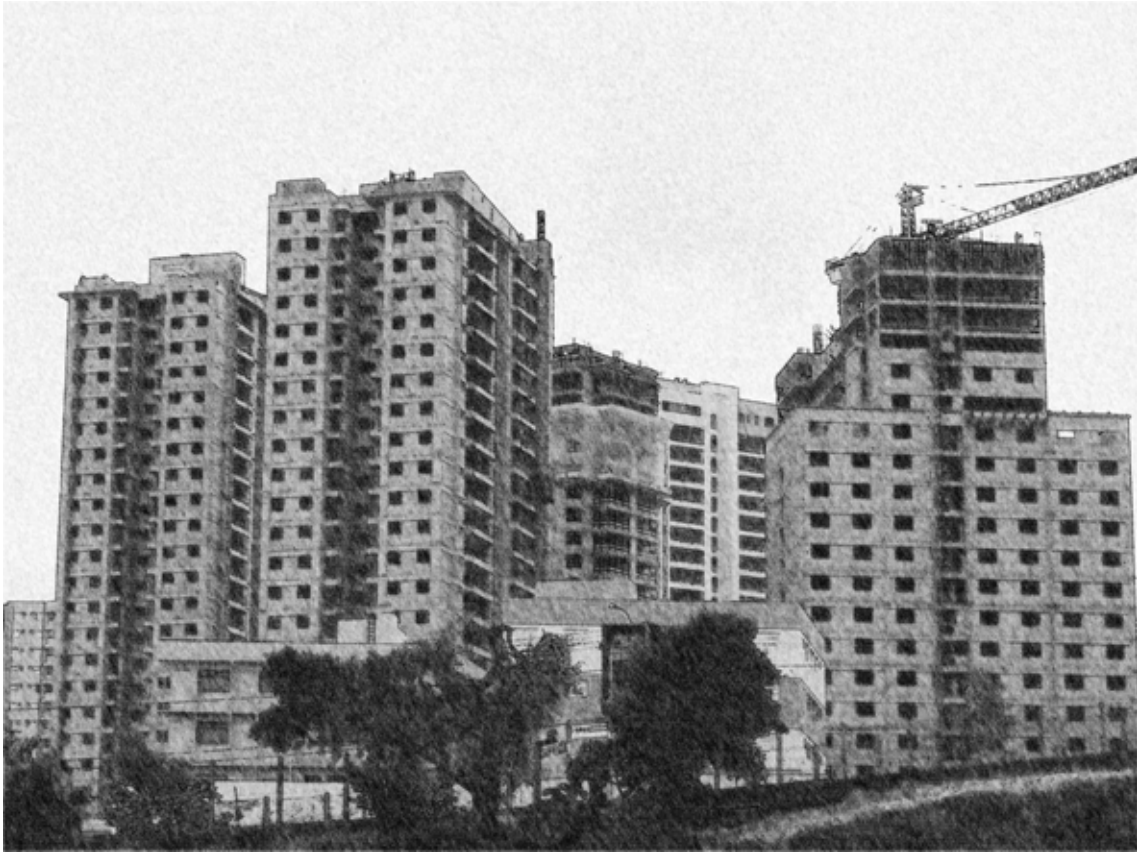
Edifício em obras no Jardim Botânico. Ribeirão Preto. Foto: Arquivo pessoal do autor deste trabalho
