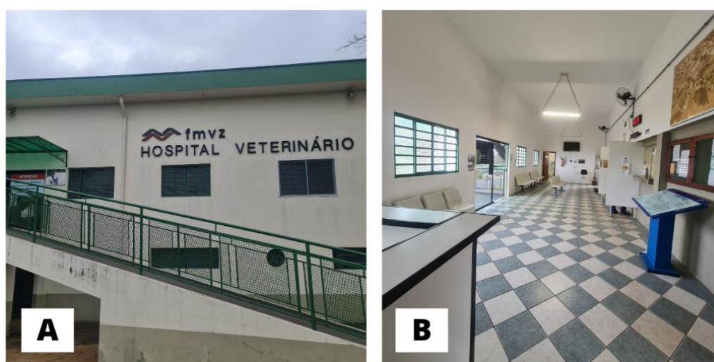
Figura 1. Estrutura do Hospital Veterinário da FMVZ - UNESP, Campus Botucatu - SP. A. Fachada do hospital. B. Recepção e triagem. Fonte: Acervo pessoal.
