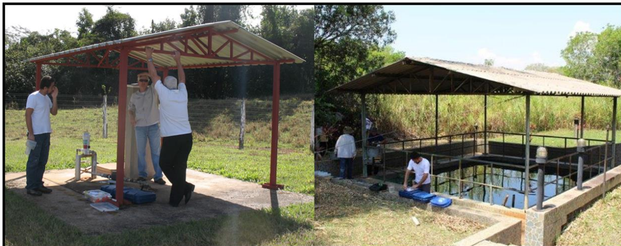
Figura 11. Fotos dos pontos amostrados no local de estudo: à esquerda, o poço de monitoramento; à direita, a nascente analisada durante a pesquisa.
