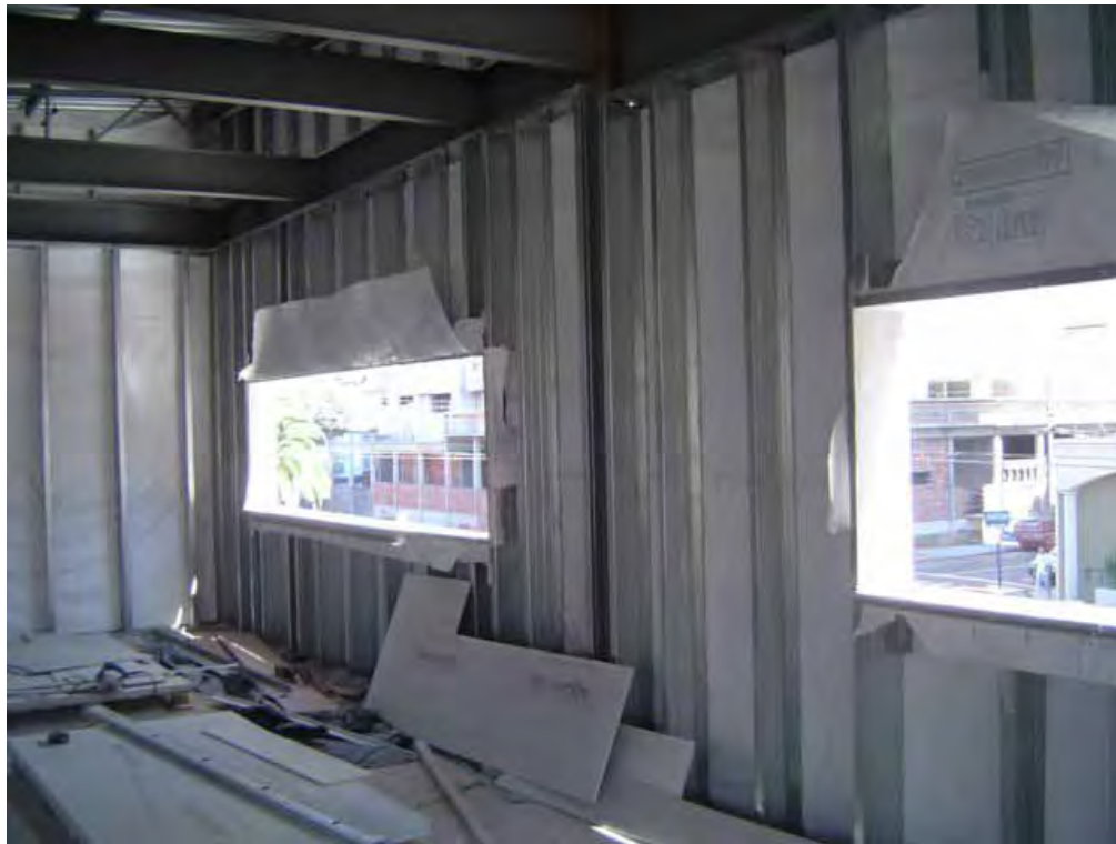
Foto 3.6 – Painel não-estrutural com abertura
