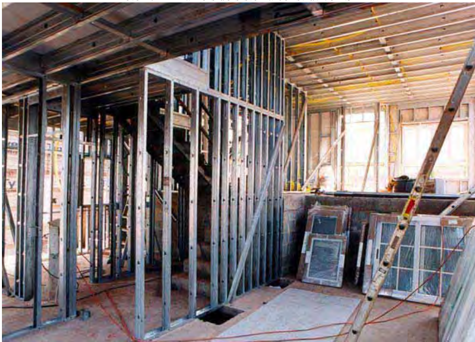
Foto 2.22 - Painéis do sistema construtivo LSF
