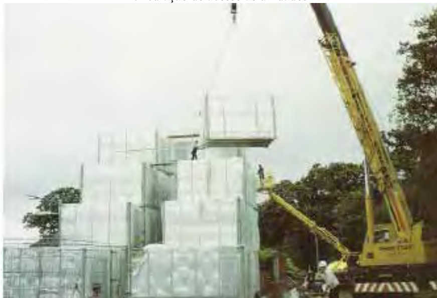
Foto 2.21- Unidades modulares empilhadas na forma da construção final; o vazio que se vê ao centro formará a circulação de acesso às unidades
