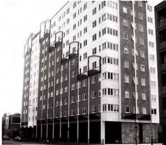
Foto 2.17 - Reforma de fachada usando Light Steel Framing
