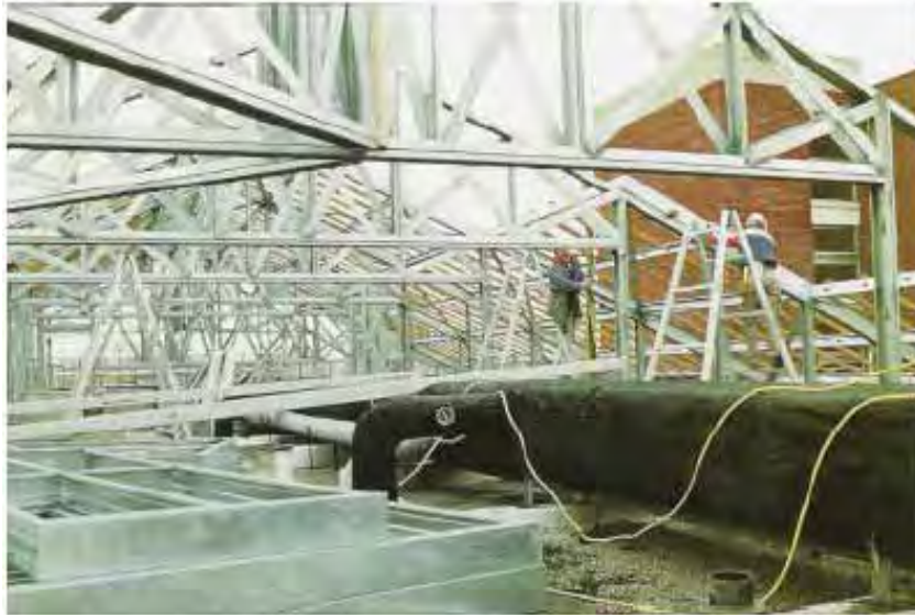
Foto 2.16 - Reforma de telhados substituindo por tesouras fabricadas com perfis formados a frio
