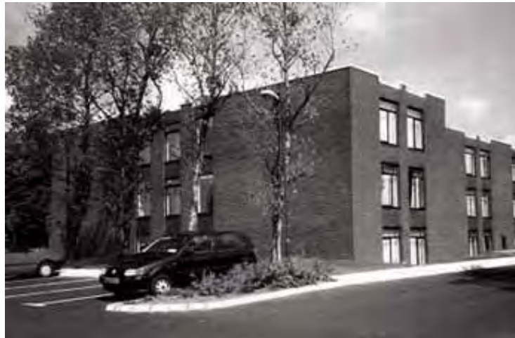
Foto 2.6 - Edifício em Dublin - Irlanda
