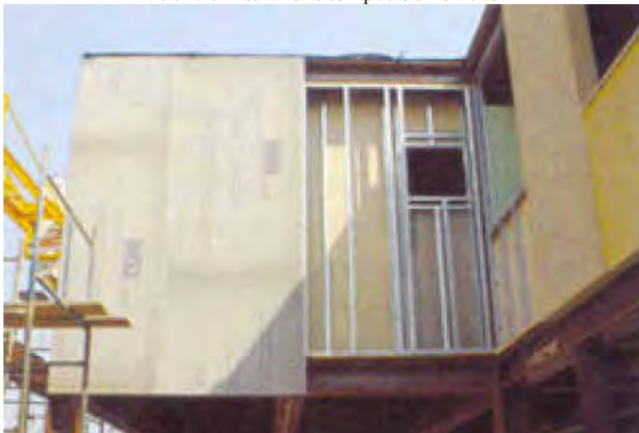
Foto 2.28 - Fechamento com placas cimentícias
