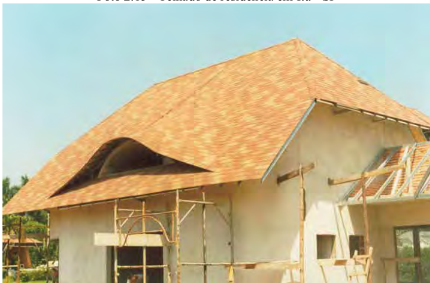
Foto 2.15 - Telhado de residência em Itu - SP
