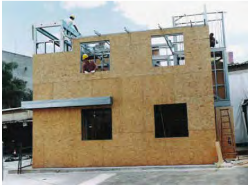
Foto 2.27 - Fachada com fechamento externo em OSB
