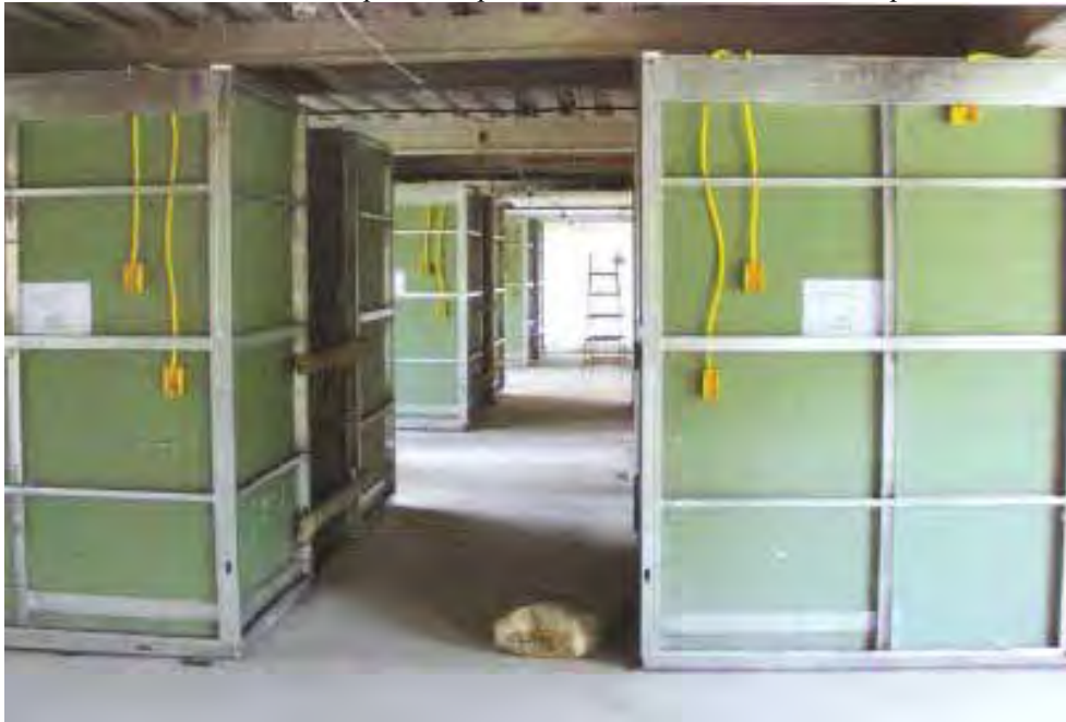
Foto 2.13 - Módulos de banheiros prontos e posicionados no Hotel Mondial Airport Business – SP
