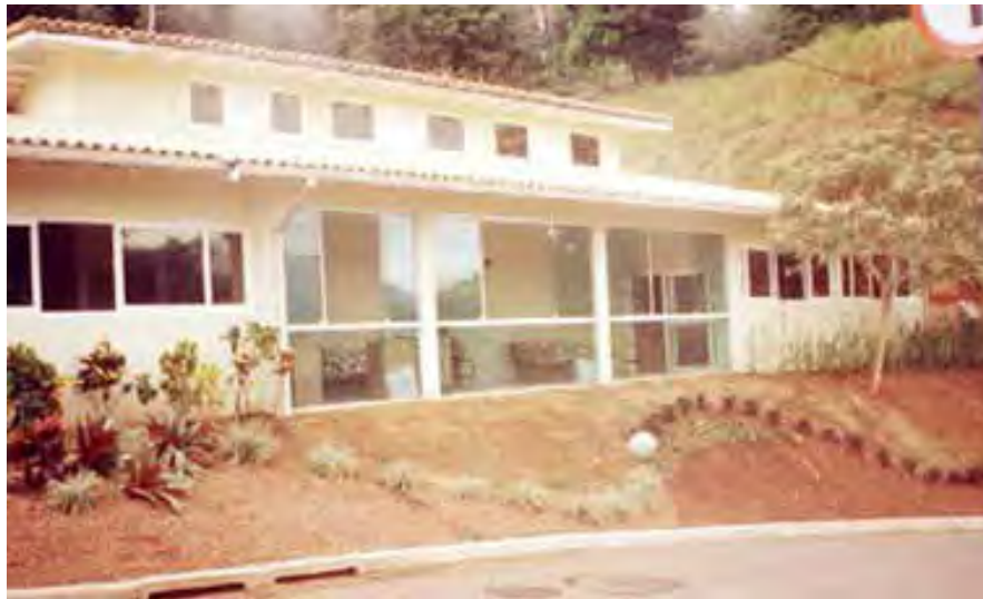
Foto 2.12 - Clínica em Belo Horizonte - MG
