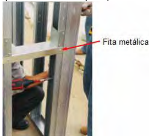
Foto 3.4 - Bloqueador e fita fixados ao painel para travamento horizontal
