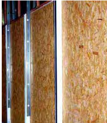
Foto 3.3 - Pannel em LSF com fechamento em OSB
