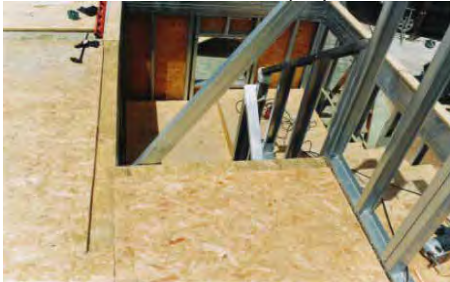
Foto 2.23 - Placas de OSB utilizadas para laje seca
