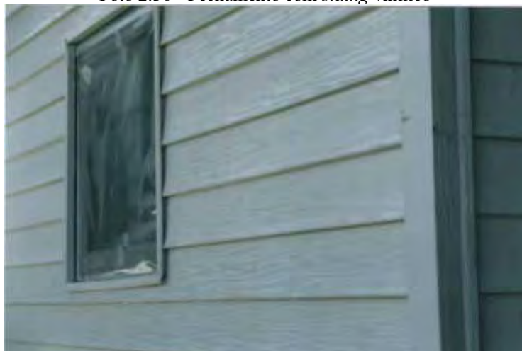
Foto 2.30 - Fechamento com siding vinílico
