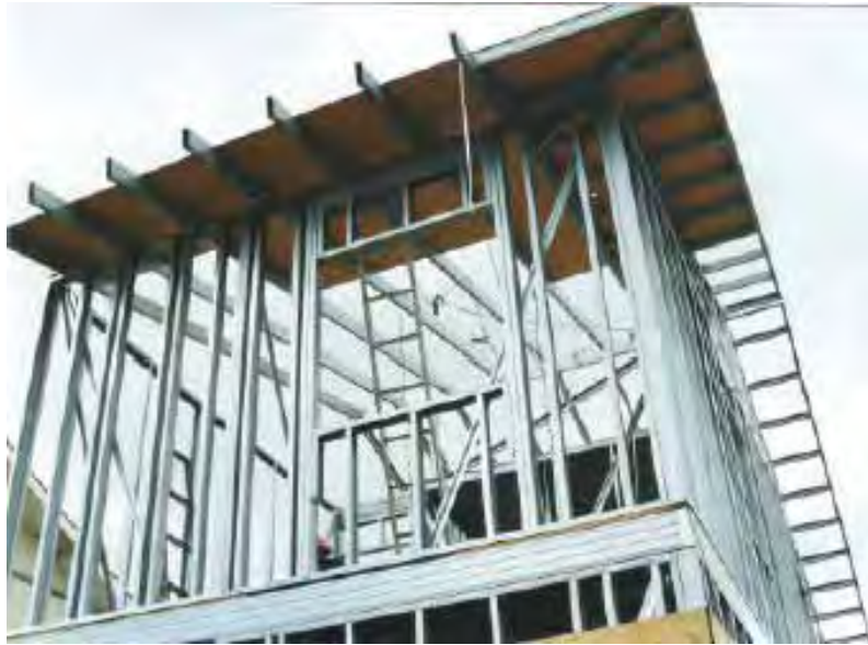
Foto 2.24 - Cobertura com placas de OSB para fixação de telhas shingles
