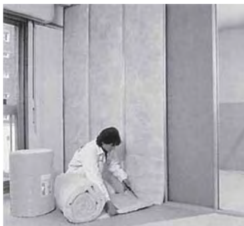
Foto 2.25 - Instalação de lã de vidro em painel
