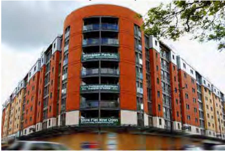
Foto 2.14 - Edifício na Inglaterra formado por 1425 módulos em LSF
