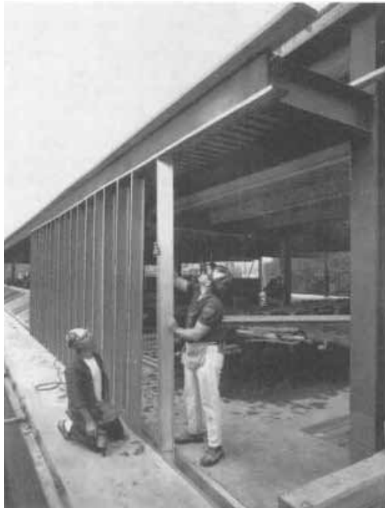
Foto 2.18 - Steel Framing montado pelo método stick
