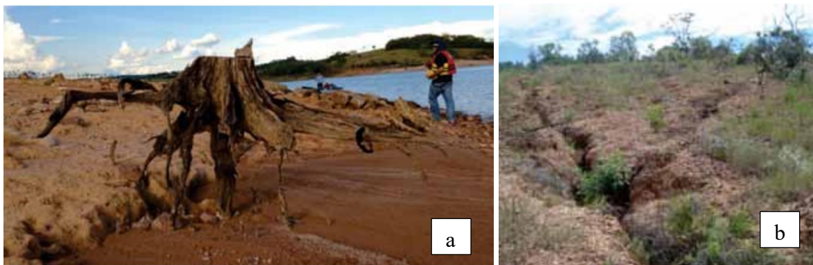
Figura 4 - Erosão superficial (a) laminar, (b) linear.
