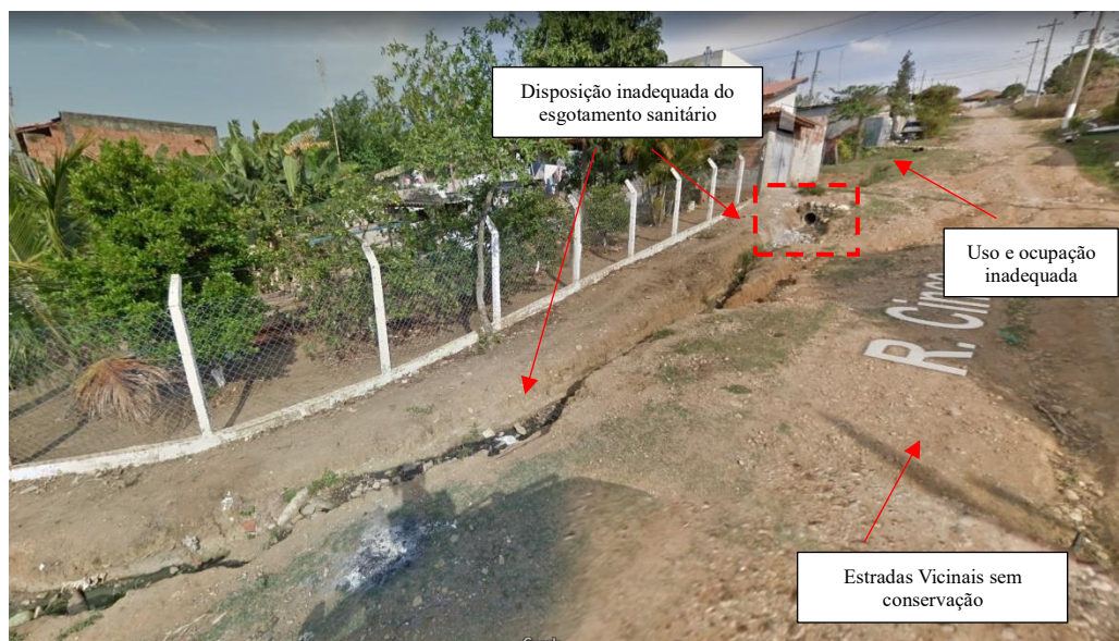
Figura 1 – Processos erosivos na região da bacia do Rio Paraíba do Sul – bairro Pingo de Ouro – Guaratinguetá/SP.
