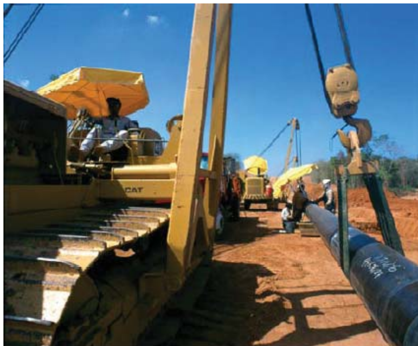
Figura 2 – Construção de uma linha dutoviária nos dias atuais (HOPKINS, 2007).
