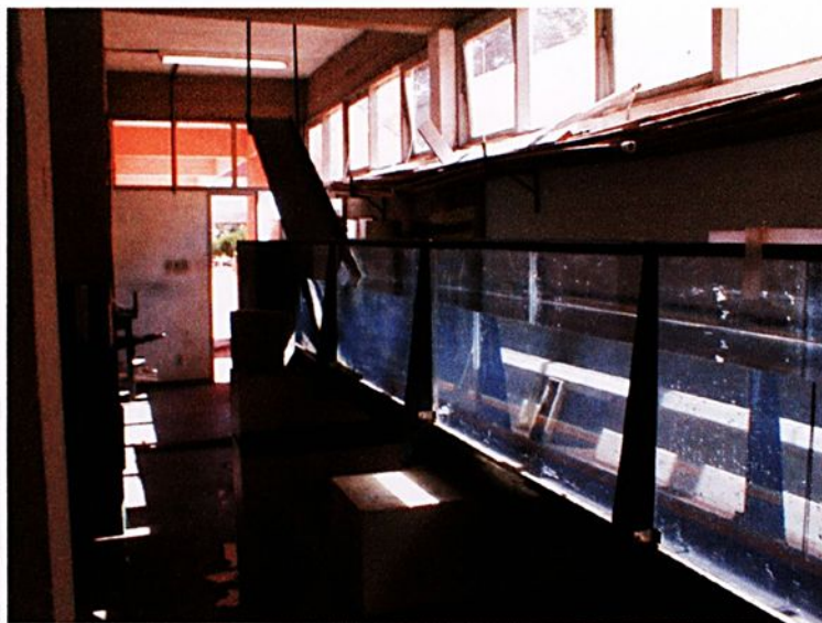
Figura 23 - Detalhe da rampa de lançamento.
