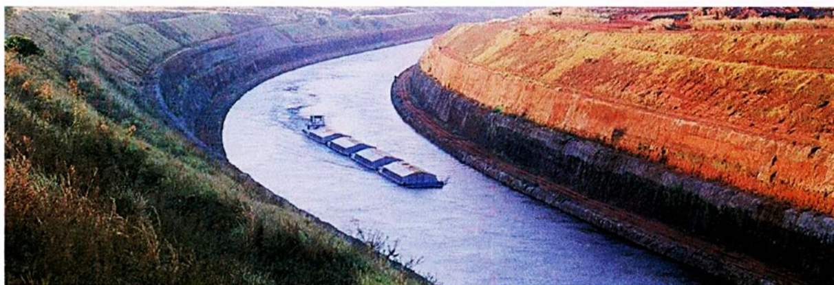
Figura 19 - Canal de Pereira Barreto (FONTE: CESP)
