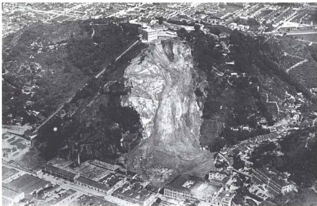
Figura 6 - Escorregamento rotacional ocorrido em 1928 no Monte Serrat, Santos (SP), com destruição de parte da antiga Santa Casa e contabilizou mais de 80 mortes. Fonte: Foto do Arquivo de C. M. Nunes, in Tominaga (2007).
