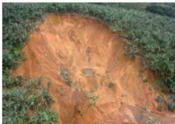
Figura 7- Escorregamento rotacional ocorrido em dezembro de 2008 na cidade de Jaraguá do Sul (SC), (arquivo do IG). Fonte: Tominaga (2012)
