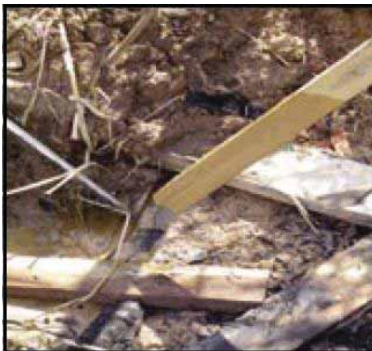
Figura 18 – Surgência de água, causando a instabilidade do talude
