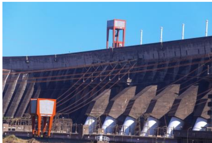
Figura 11 - Pórticos utilizados na Usina de Itaipu
