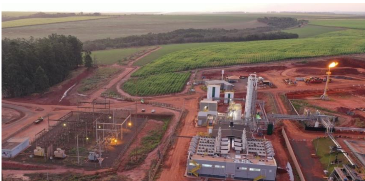
Figura 13 - Usina de biogás da Raízen localizada em Guariba-SP.
