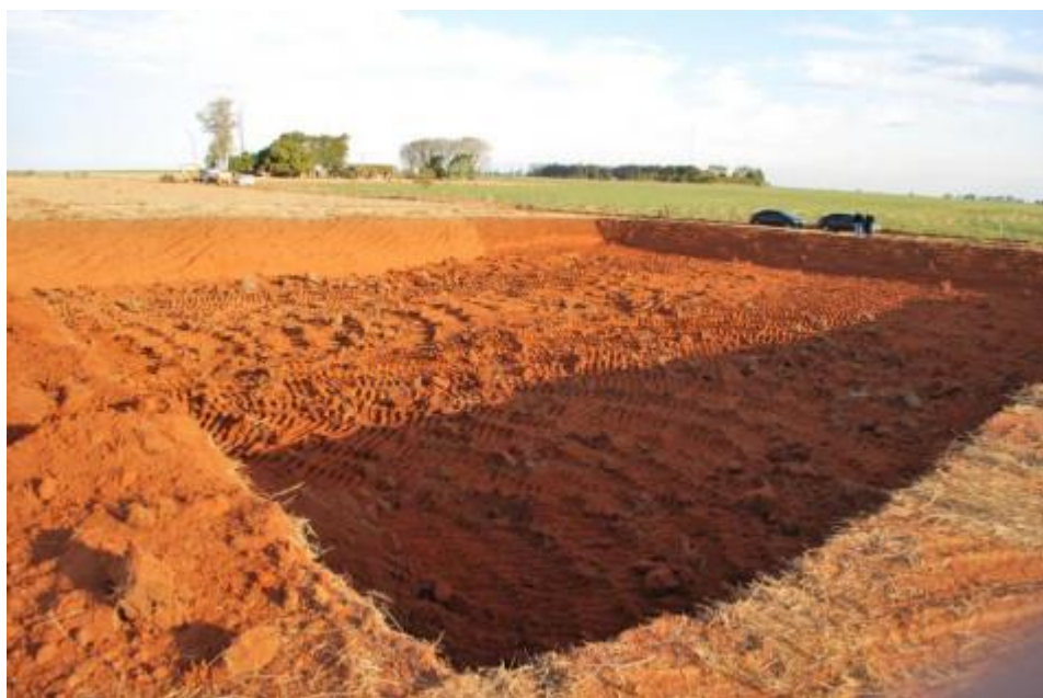
Figura 5 - Início das obras para construção do aterro do CIPP (2019).
