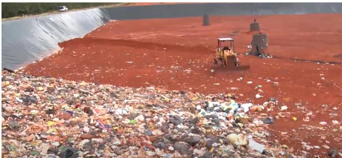
Figura 8 - Aterro do CIPP em operação (08/2022).
