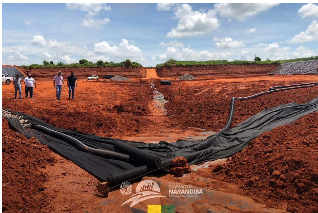
Figura 7 - Etapa finalização de construção do aterro do CIPP (01/2022).
