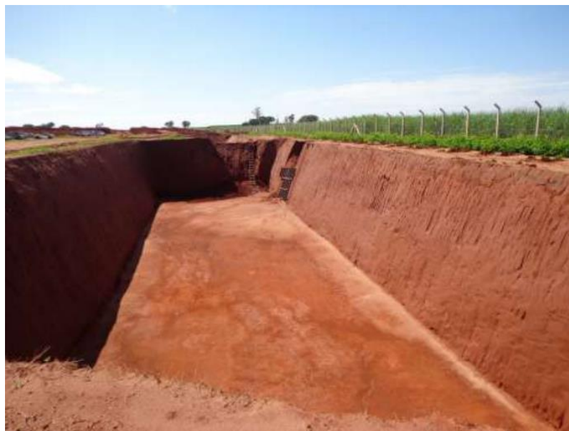
Figura 6 - Lagoa para acúmulo do percolato (chorume e águas das chuvas) no aterro do CIPP.
