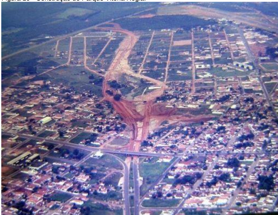
Figura 10 - Construção do Parque Vitória Régia.
