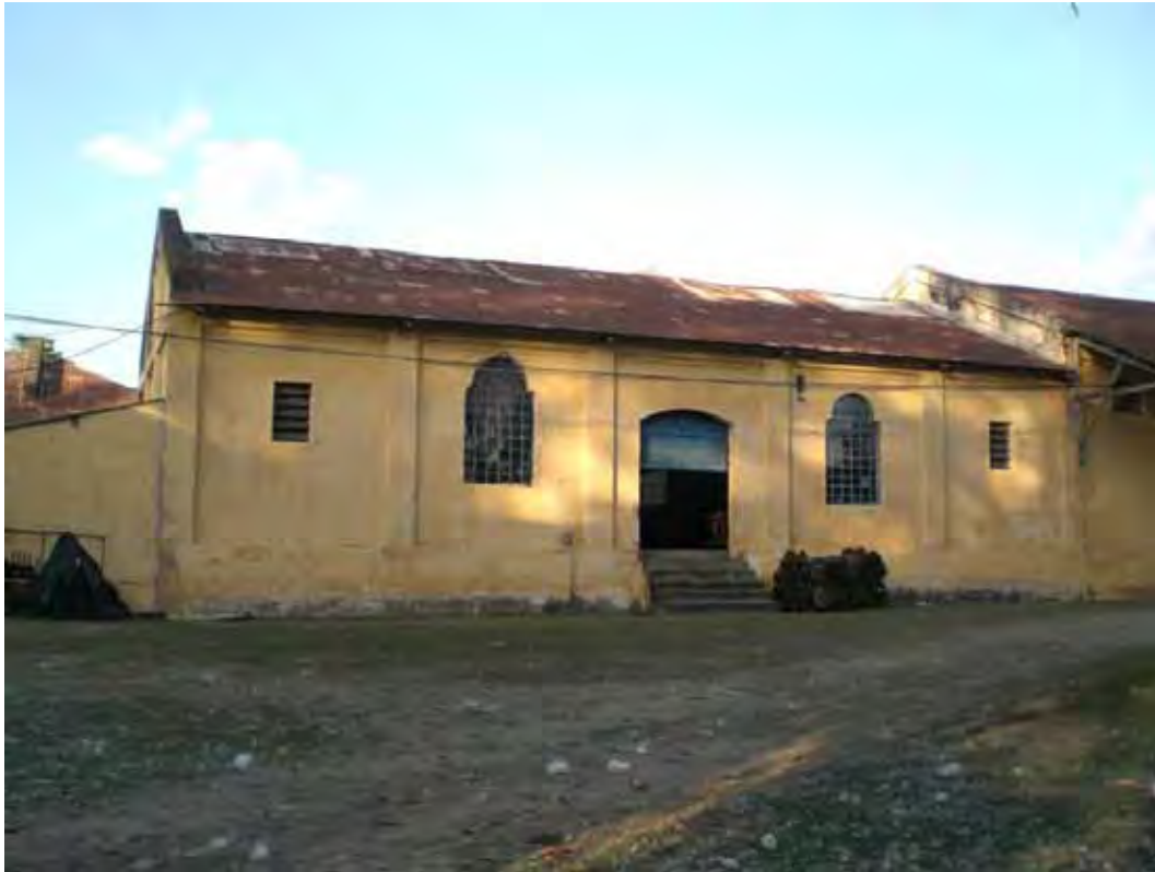
Figura 24 – fachada, mostrando parte antiga.
