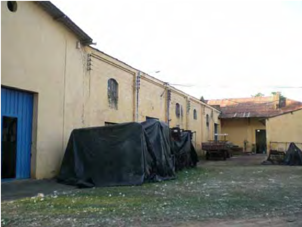
Figura 25 – fachada, mostrando parte antiga, com ampliação.
