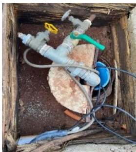
Figura 31 - Foto do poço do colégio SOPHUS
