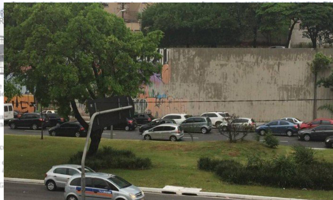
Figura 109 – Murais da Avenida 23 de maio cobertos pelo cinza em São Paulo
