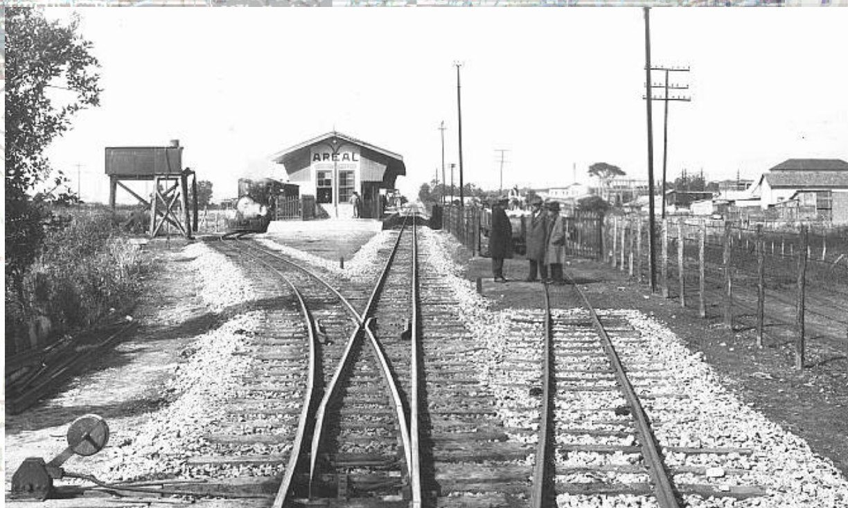
Figura 27 – Estação Areal (antiga Parada 3). Imagem de 1900.
