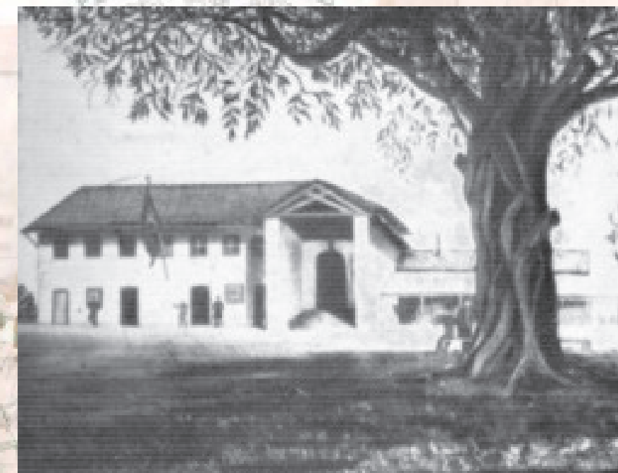
Figura 20 – Solar dos Andradas.
