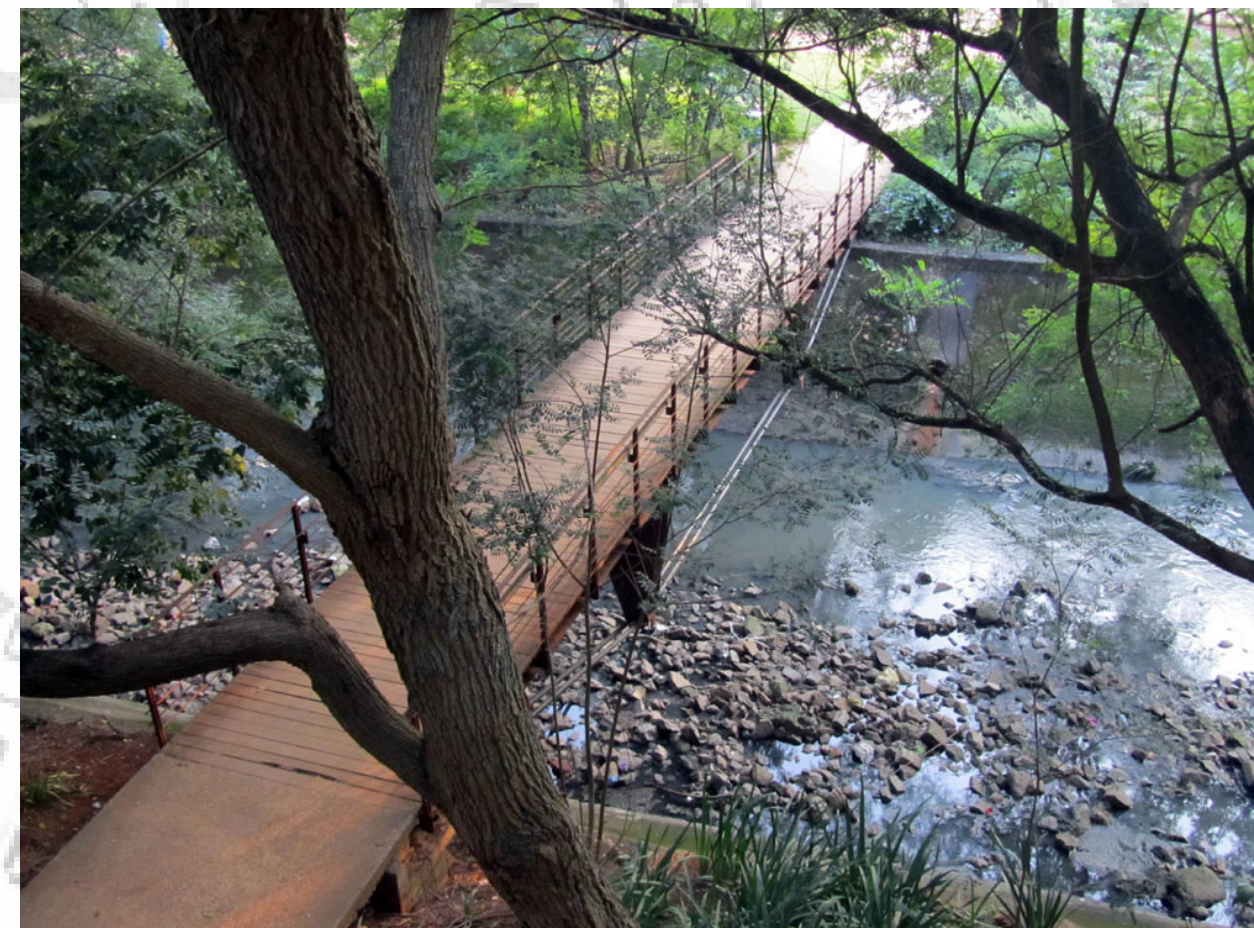
Figura 50 – Ponte sob o Córrego do Carandiru
