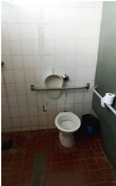
Figura 19 – Banheiro feminino na escola “A”.
