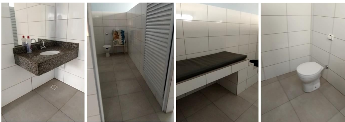
Figura 21 – banheiros recém-reformados na escola “C”.
