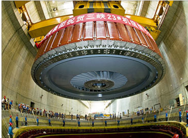
Figura 9 - Descida do rotor da usina de três gargantas.
