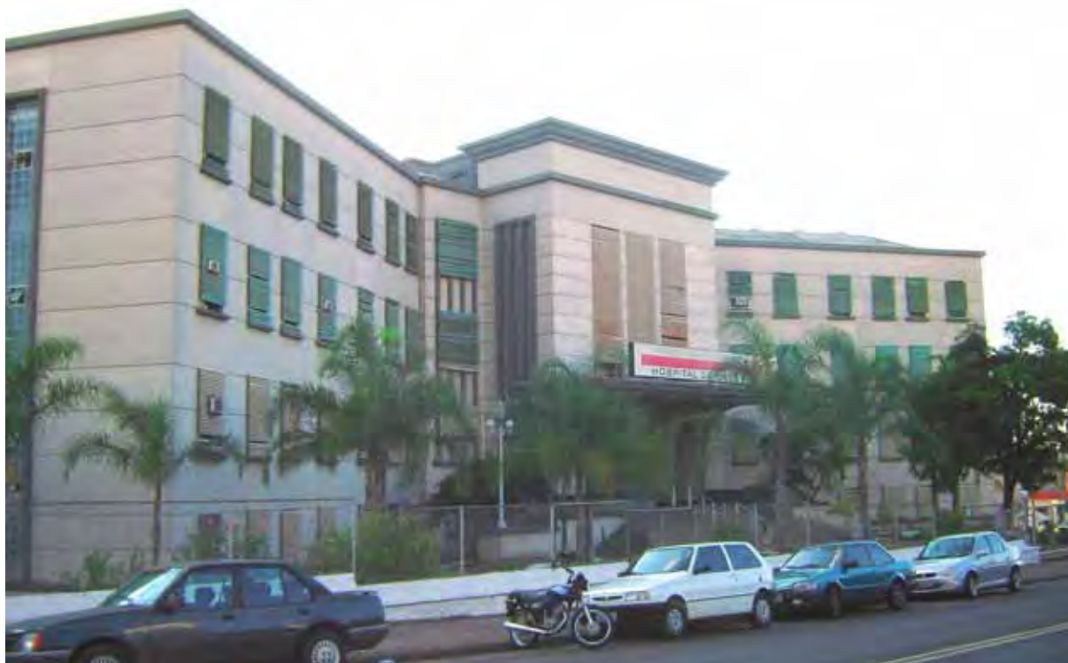
Figura 4.02 – Fotografia da frente do Hospital de Base de Bauru.
