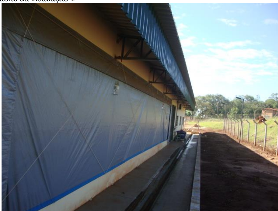
Figura 9 - Lateral da instalação 1
