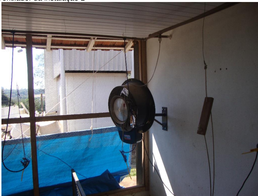
Figura 13 - Ventilador da instalação 2
