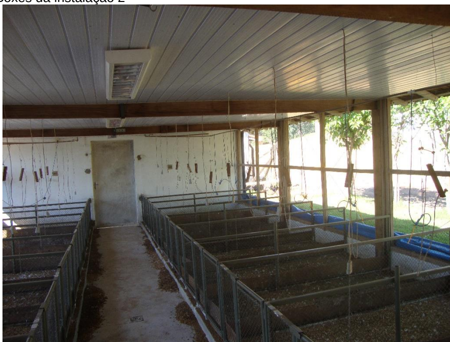
Figura 14 - Boxes da instalação 2
