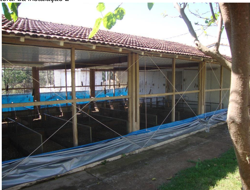
Figura 12 - Lateral da instalação 2
