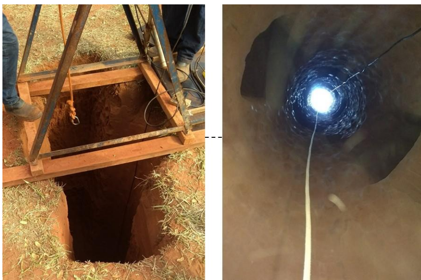
Figura 43. Poço exploratório escavado até 16m de profundidade na área estudada.
