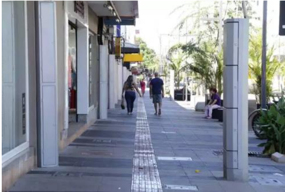
Figura 17 – Calçada com tampa de caixas de inspeção niveladas
