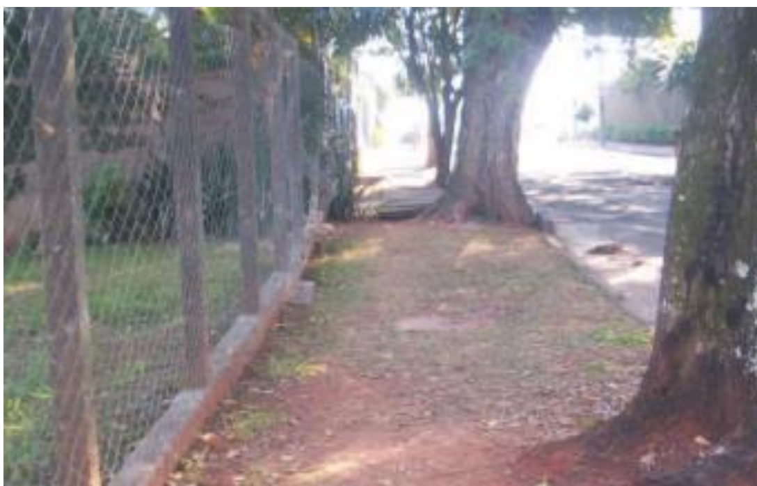
Figura 1 – Exemplo de inexistência de calçada
