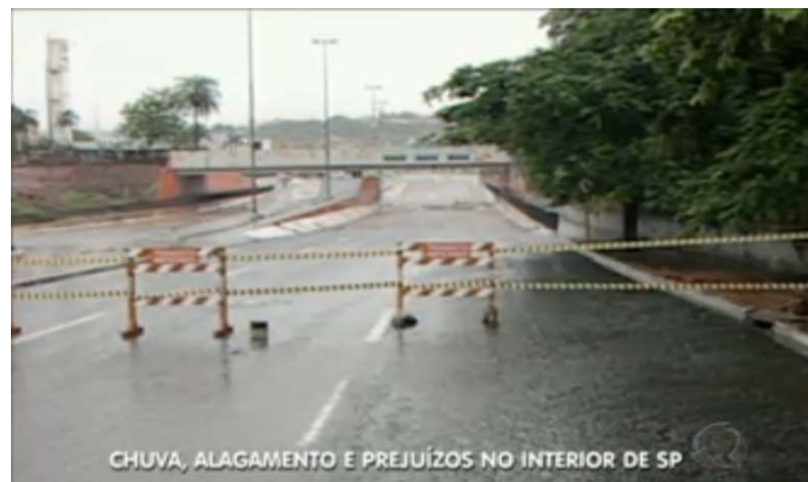
Figura 4: Ocupação de fundo de vale por pela Av. Nações Unidas. Chuva causa danos ao local. Córrego das Flores, Bauru-SP. Fonte: Rede Record
