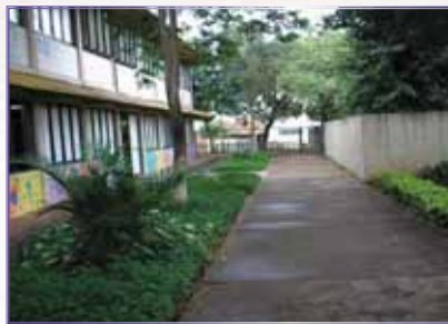
Figura 16: Área externa da EMEI "Caic" José Toledo Filho
