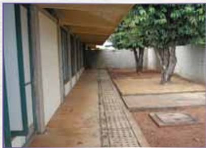
Figura 15: Área externa da EMEI "Caic" José Toledo Filho
