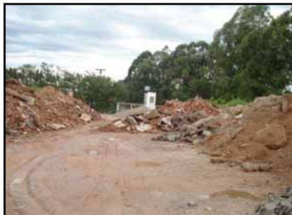
Figura 7: Recepção de entulho – São Carlos
