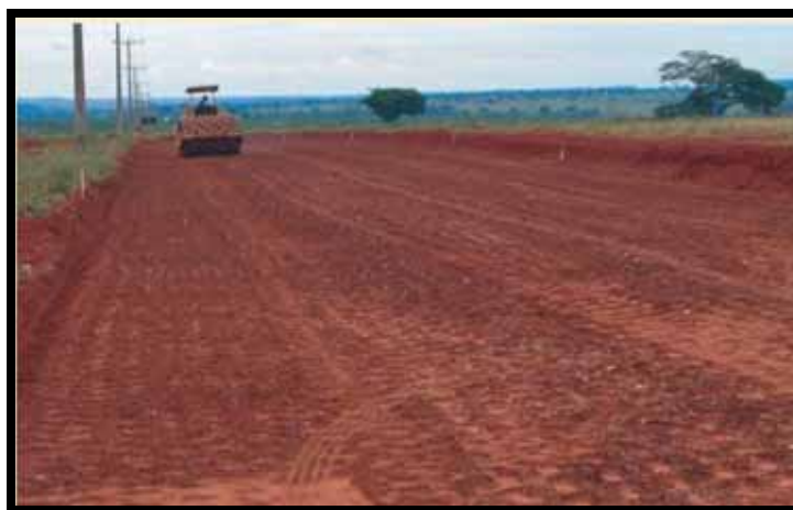
Figura 24: Construção de base de pavimento com a utilização de RCD reciclado como brita corrida no Município de Uberlândia-MG Fonte: Dias et al. (2007)
