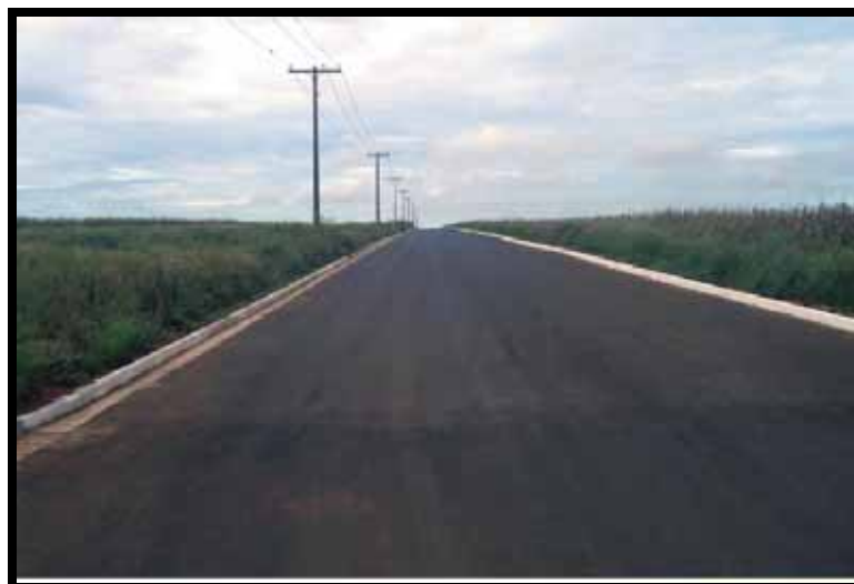
Figura 25: Asfalto aplicado sobre base preparada com RCD reciclado na forma de brita corrida no Município de Uberlândia-MG. Fonte: Dias et al. (2007)
