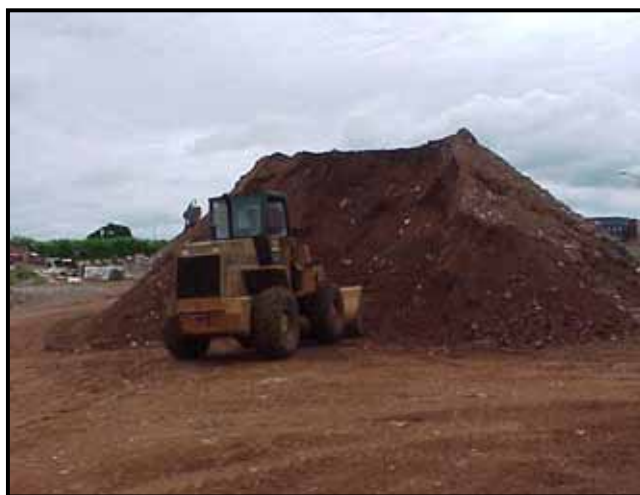
Figura 8: Pátio de recepção de entulho da Usina de Reciclagem de São José do Rio Preto (predominância de solos) Fonte: (Autor, 2009)
