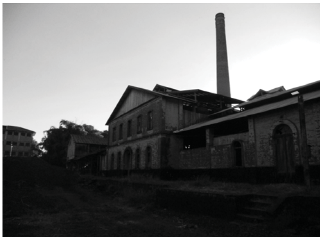
Foto 1: Engenho Central. Fonte: autor. 2011.
