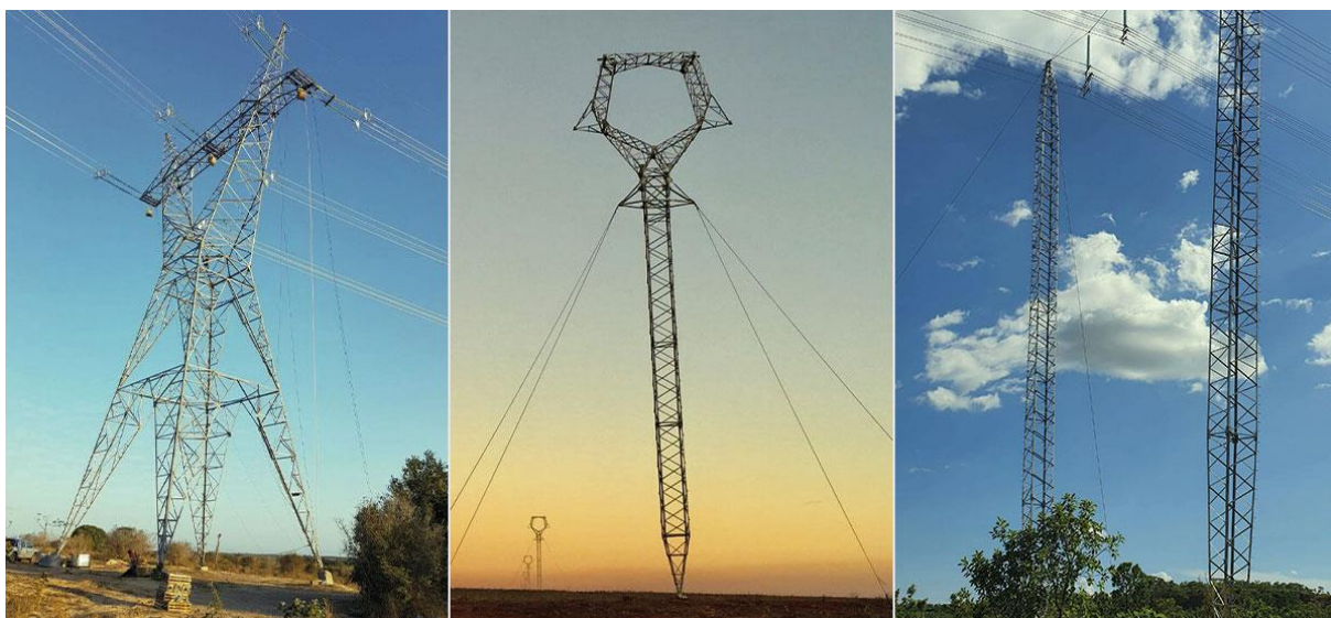
Figura 7 – Linhas de Transmissão de Energia Elétrica
