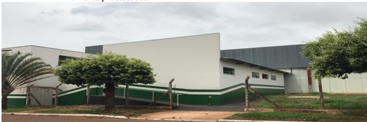
Figura 15 – Infraestrutura construída com recursos do Microbacias II para produtos minimamente processados
