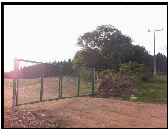
Figura 17: Implantação de portão no Aterro de Inertes em outubro de 2016.
