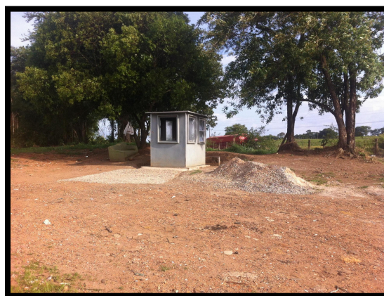
Figura 18: Implantação de guarita no Aterro de Inertes em outubro de 2016.
