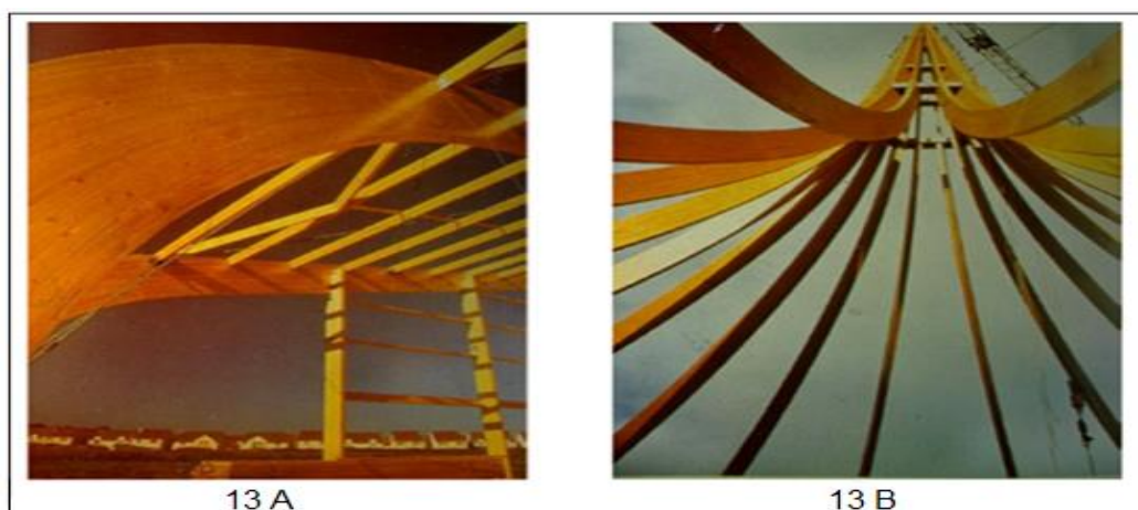
Figura 13 - Exemplos de construções realizadas com MLC.
