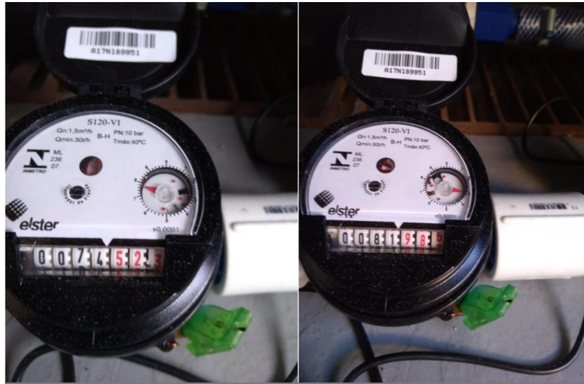
Figura 4.14 – Leituras realizadas no hidrômetro do sistema de recirculação de água, ao início e fim do período de coleta de dados.
