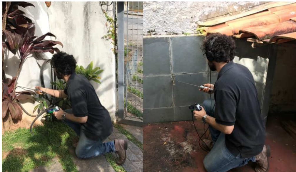
Figura 1.2 – Técnico realizando varredura em rede de água para a detecção do vazamento.
