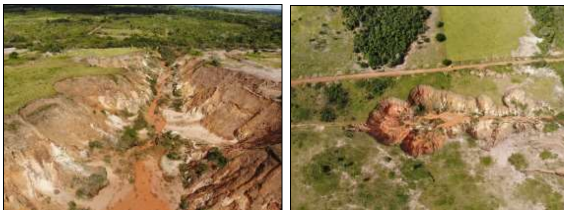
Figura 51. Processos erosivos em área de pastagem identificados por sobrevoo Fotos: Josiel Doriguette de Oliveira (2018). Fonte: Trabalho de campo (2018)
