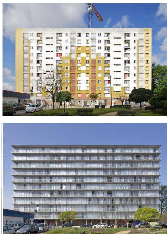
Fig. 09. Fotografia de antes e depois da fachada do edifício de 530 habitações em Grand Parc de Lacaton & Vassal, 2016 Fonte: Site dos Arquitetos.
