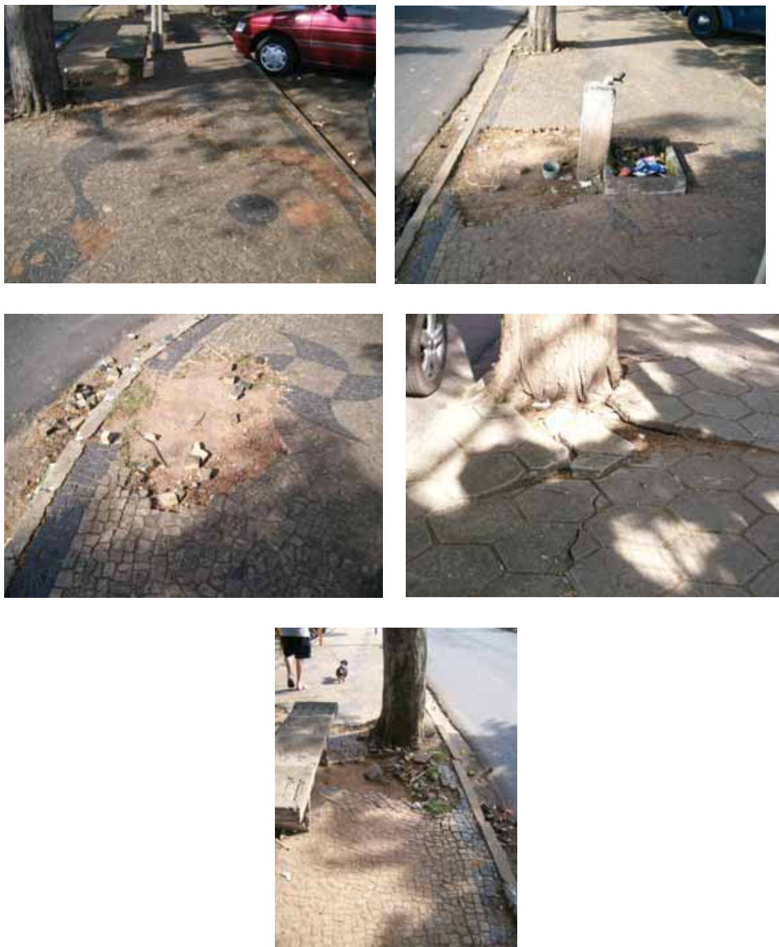
Figura 8 - Calçadas UBS da Avenida 29
