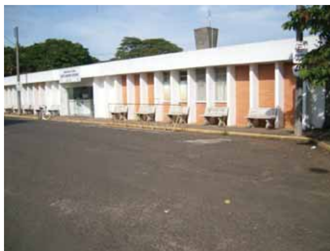
Figura 15 - Bicletário UBS avenida 29
