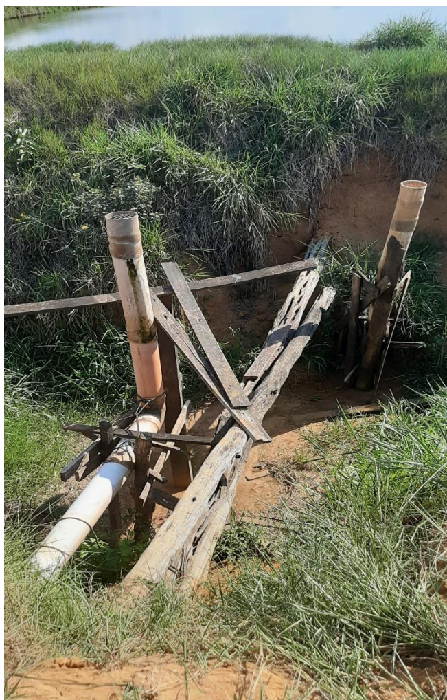
Figura 39 - Drenagem de viveiros tipo cotovelo
