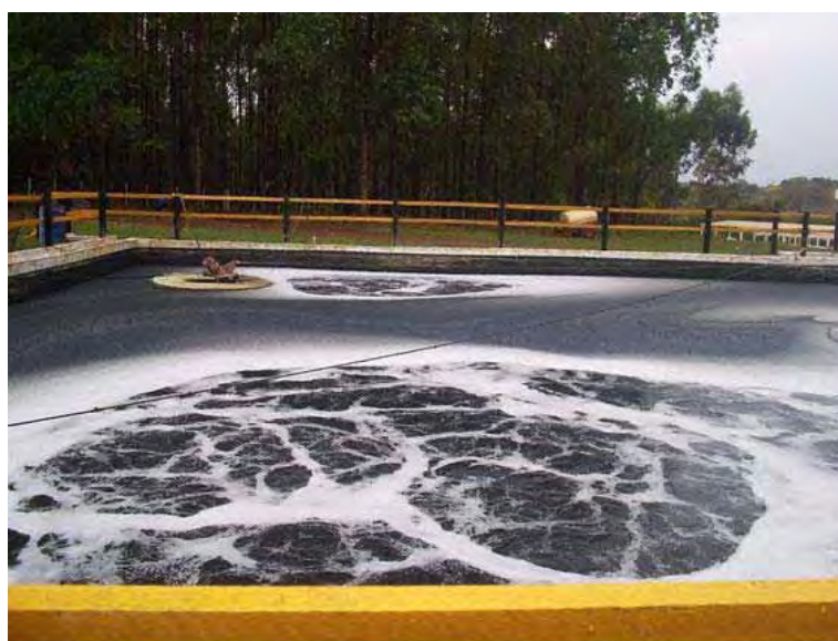
Figura 02 – Tanque de equalização de efluentes do curtume Fuga Couros
