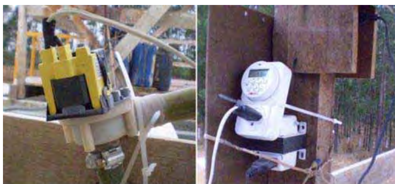
Figura 20 – Sistema de descarga de fundo do tanque de equalização
