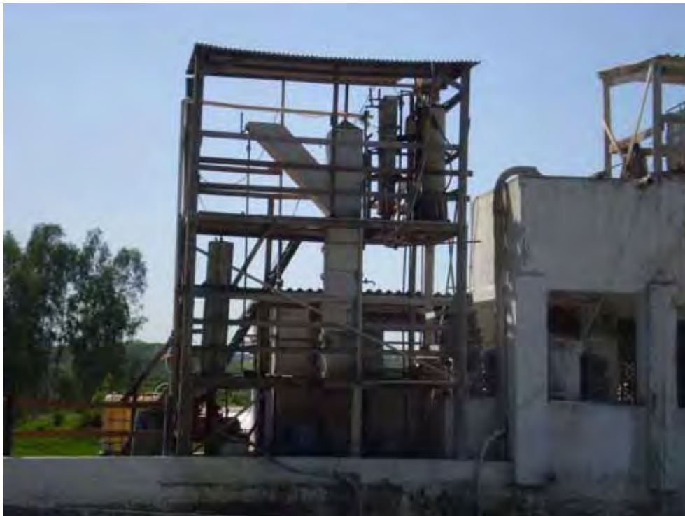
Figura 10 – Vista da estação experimental
