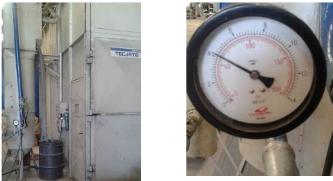
Figura 19 - Fotografia do equipamento utilizado no jateamento e barômetro de controle da pressão do jato.
