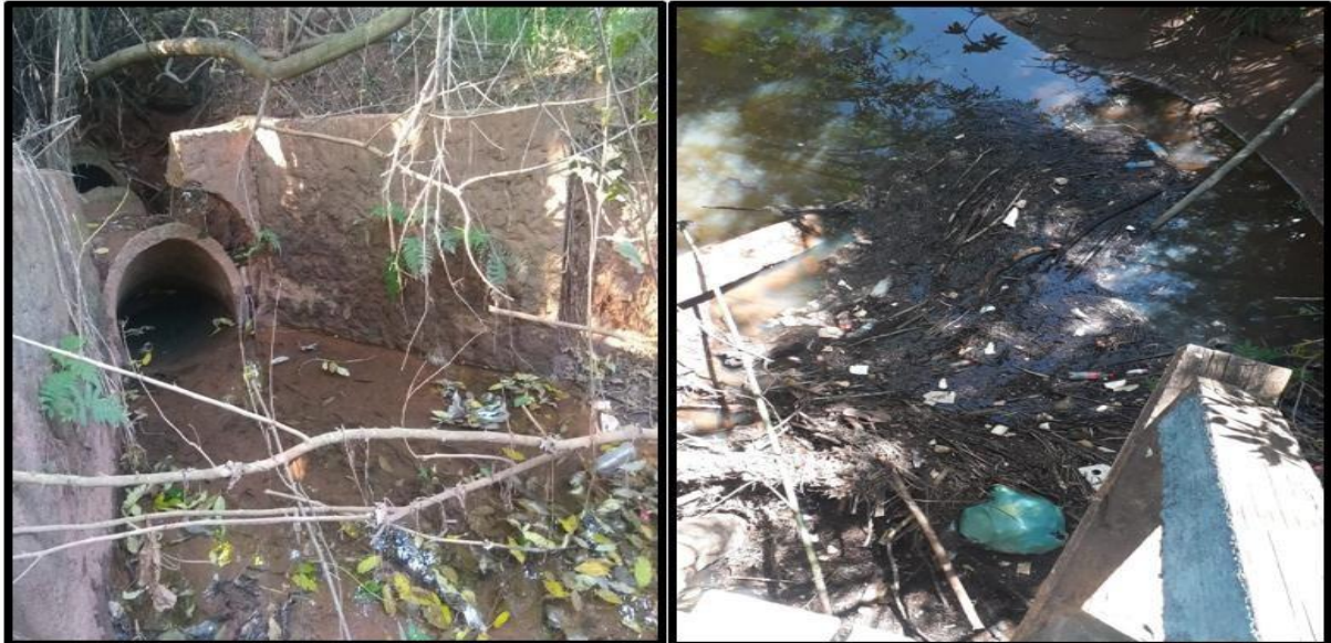
Figura 20: Tubulação inadequada diretamente no Ribeirão (esquerda) e grande quantidade de resíduos sólidos de origem doméstica (direita)
