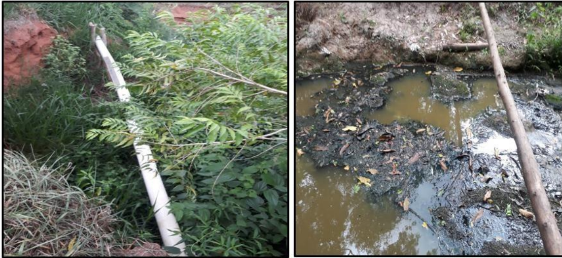
Figura 21: Tubulação de lançamento de esgoto em um corpo receptor (esquerda) e corpo hídrico com grande quantidade de matéria orgânica depositada (direita).
