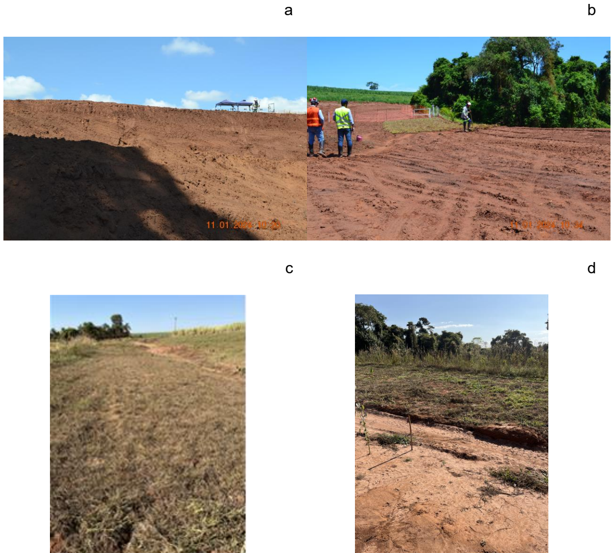
Figura 18. Processo de revegetação de taludes e patamares nas voçorocas 1 e 2: a e b) em 11/01/2024 e c e d) em 26/06/2024. Fotos: Martins Filho (2024).
