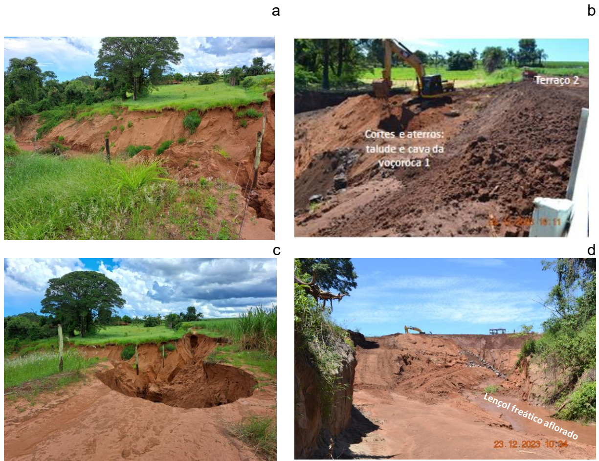
Figura 13. Retaludamento e construção de terraços patamares. Fotos: Martins Filho (2024).
