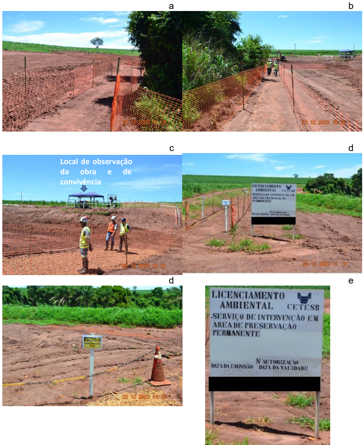
Figura 15. Imagens da área de segurança com sinalização e placas indicativas: a) corredores de acesso as obras e demais áreas; b) corredor de acesso as obras na voçoroca 2; c) área de convivência; d) entrada principal com placa de identificação; d) Estacionamento de veículos; e) Placa de Licenciamento Ambiental / CETESB. Fotos: Martins Filho (2024).
