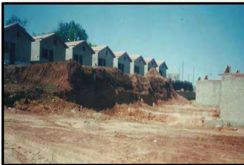
FOTOGRAFIA 4 - Casas em execução no Jardim Graminha III. Fonte: Acervo de Barbosa, L. A. (2004)
