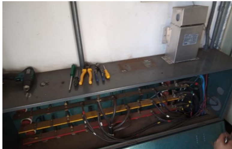
Figura 49: Retirada das células capacitivas antigas.
