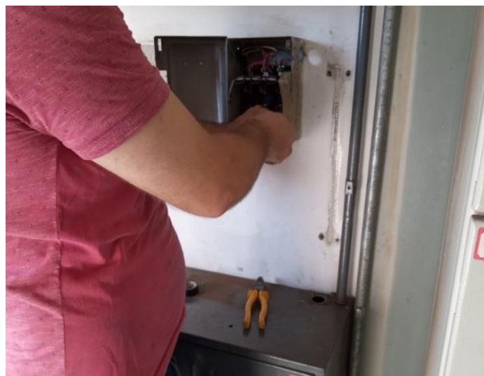
Figura 50: Retirada das chaves de acionamento do banco antigo.
