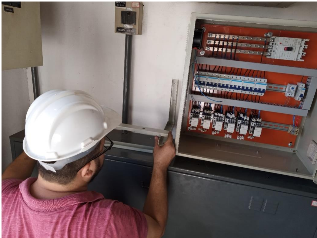
Figura 52: Fixação da estrutura para comportar as células capacitivas.
