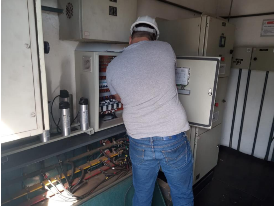
Figura 57: Passagem dos cabos para alimentação e acionamento do banco.
