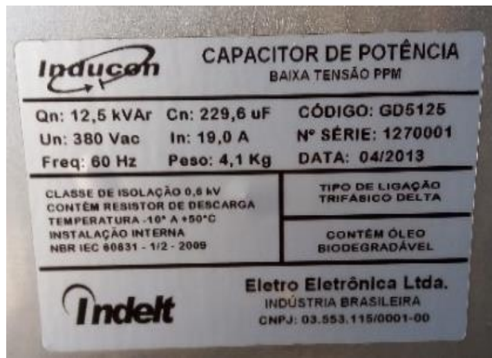
Figura 10: Banco de capacitores instalado na base de operações.
