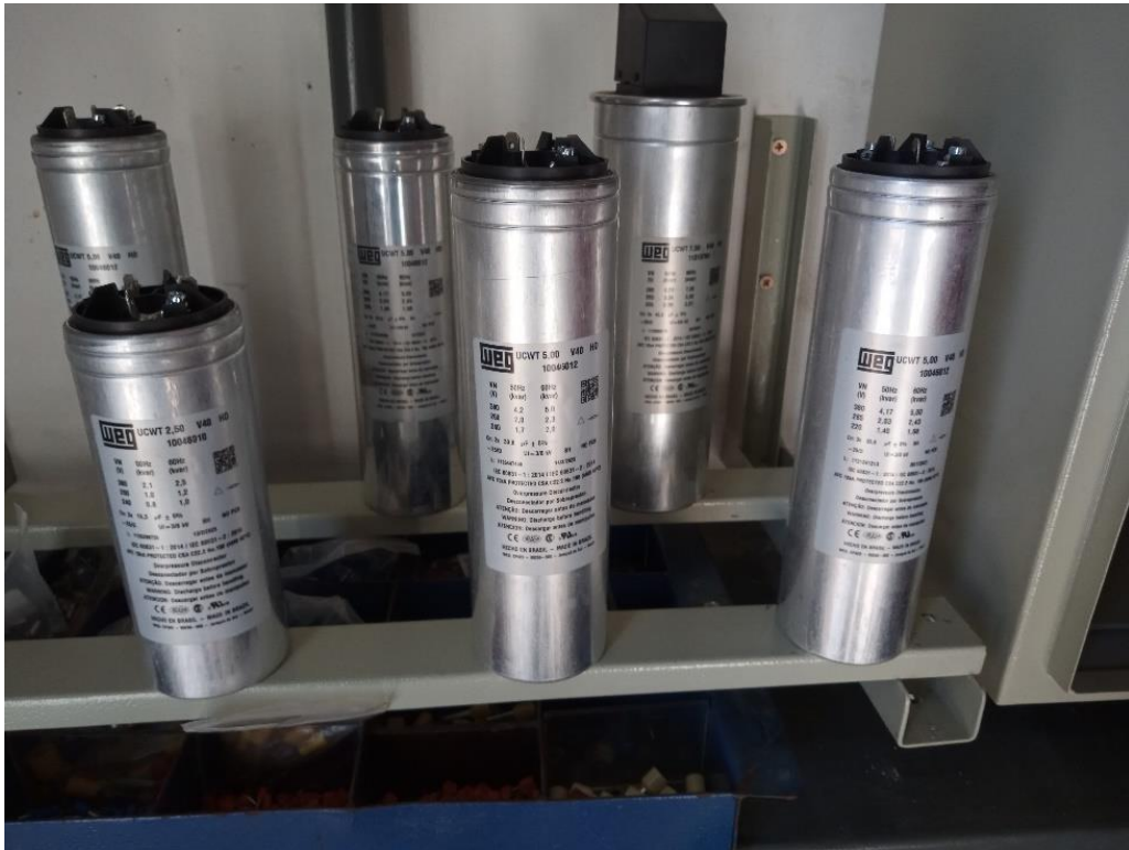
Figura 53: Células capacitivas fixadas.
