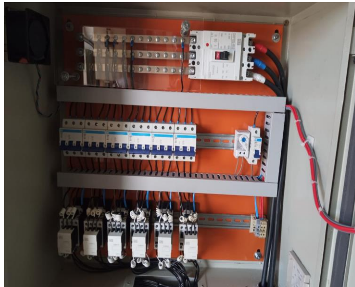
Figura 58: Cabos de alimentação do sistema de acionamento do banco passados.
