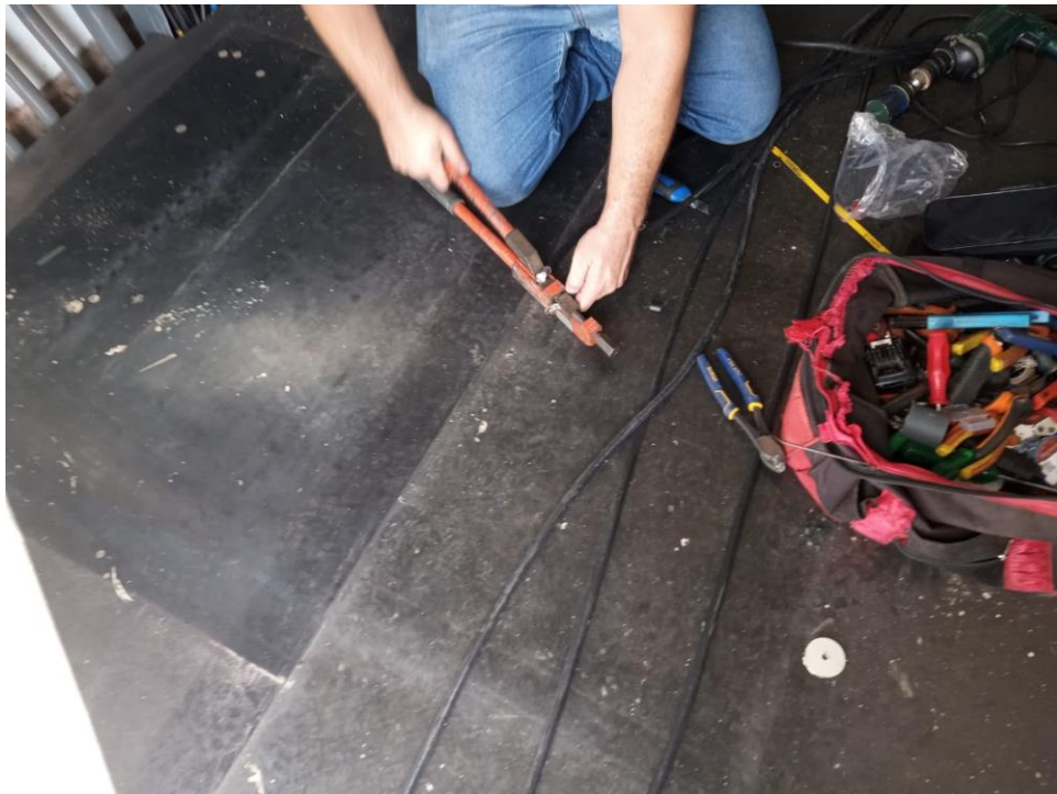
Figura 56: Crimpagem de terminais nos cabos.
